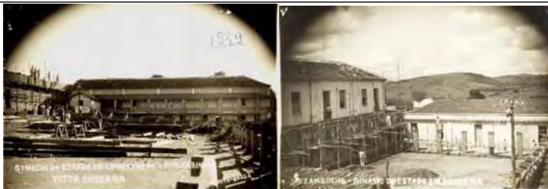
Fotos da construção da escola
