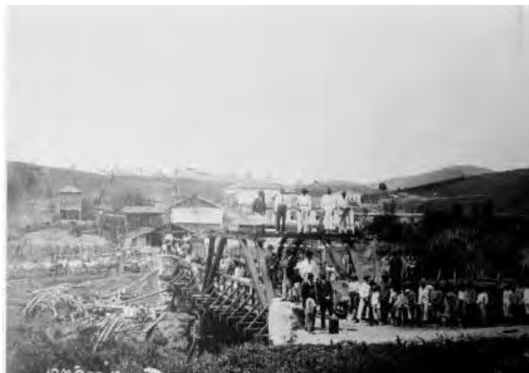
Figura 267 – Ponte de Madeira da Juréia sobre o Rio Muzambo (foto do acervo do Museu Municipal Francisco Leonardo Cerávolo)
