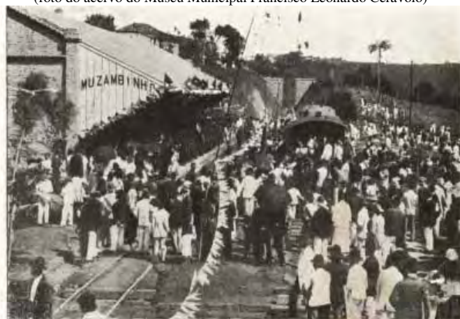
Vista da Estação da Mogyana, em Muzambinho, no dia da sua inauguração, em 6-4-1913
