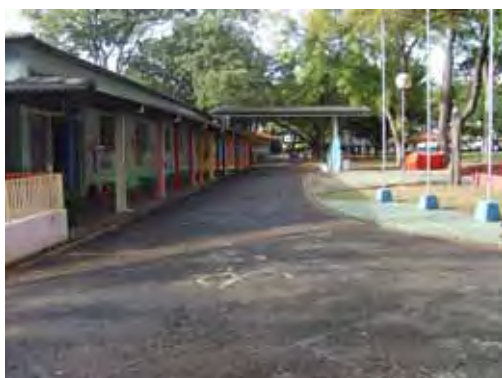
Figura 25 – Asfalto da Escola 2.
