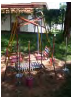
Figura 8 – Equipamento recreativo danificado.
