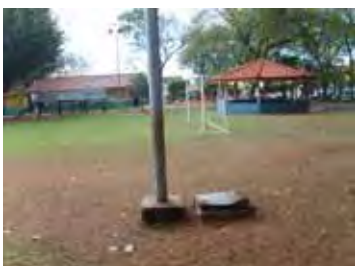
Figura 11 – Poste de luz e bloco de concreto.
