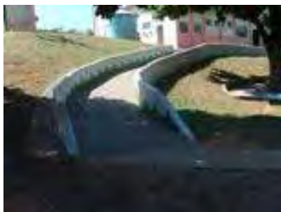
Figura 33 – Rampa da Escola 3.
