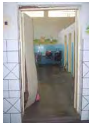
Figura 42 – Porta quebrada da Escola 5.
