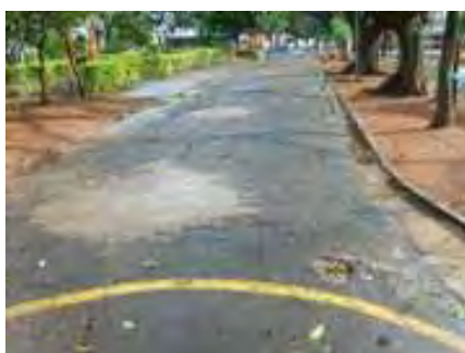
Figura 27 – Asfalto da Escola 2.
