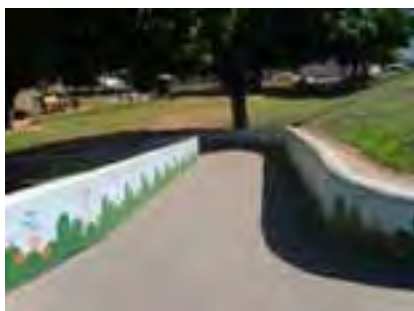
Figura 34 – Rampa da Escola 3.
