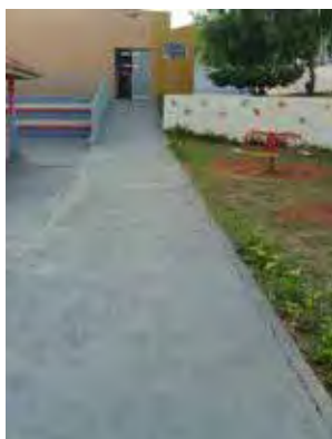
Figura 29 – Rampa da Escola 6.
