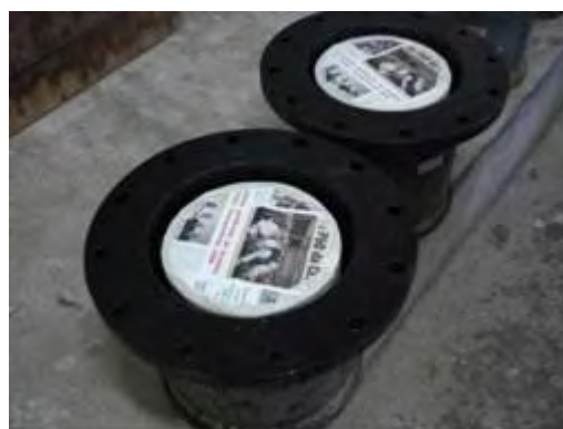
CP acoplado ao bujão – vedação das laterais com piche
