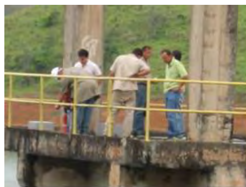
Instalação do equipamento de extração na laje da TA
