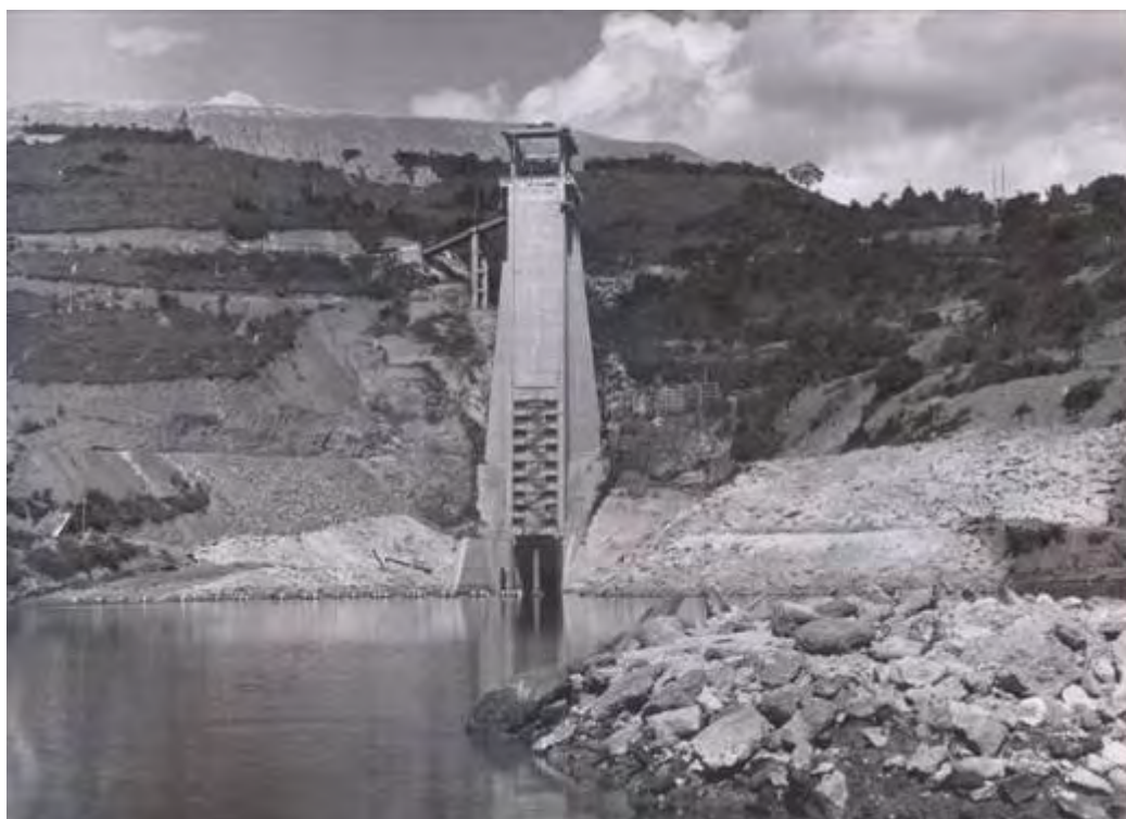
Figura 23 – Estrutura da Tomada d'água no período de construção
