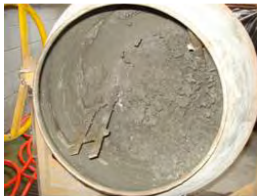
Mistura do concreto
