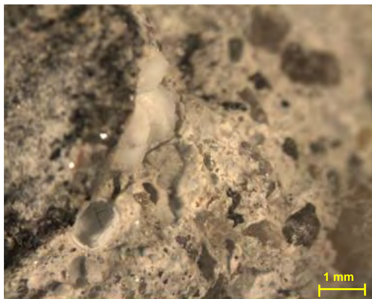
Figura 72 – Aspecto do concreto da UHE Jaguari – Fragmento 5 do testemunho
