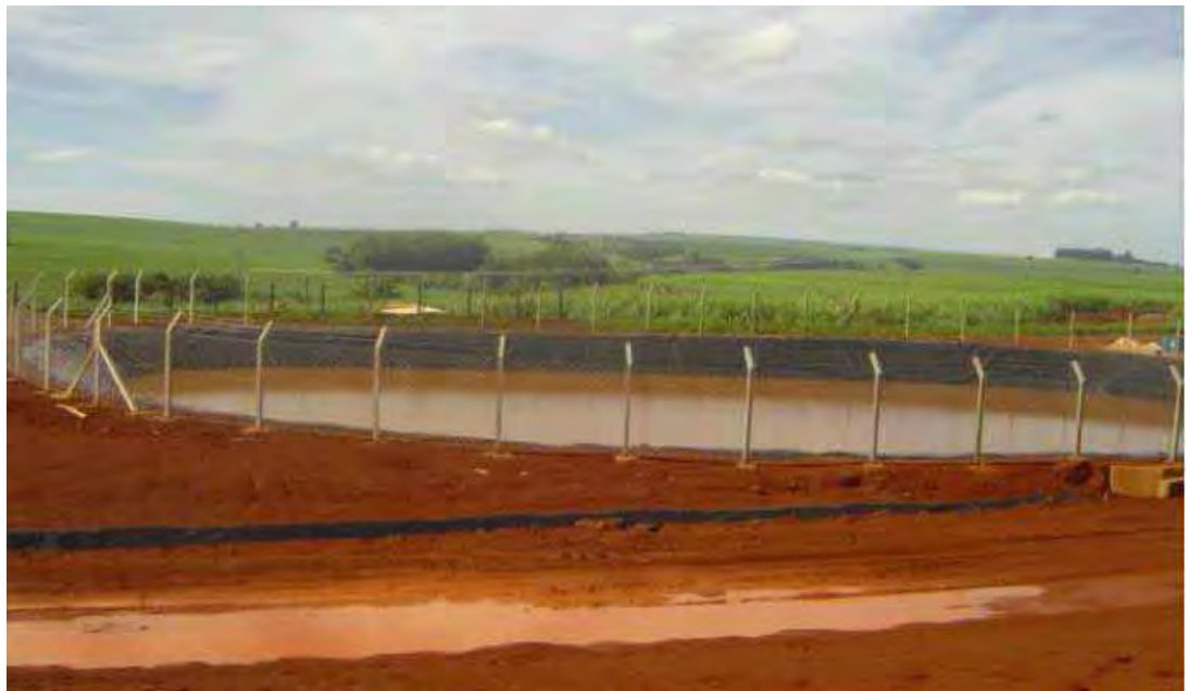
Figura 11 - Depósito de vinhaça impermeabilizado. Fonte: SOUSA (2007).
