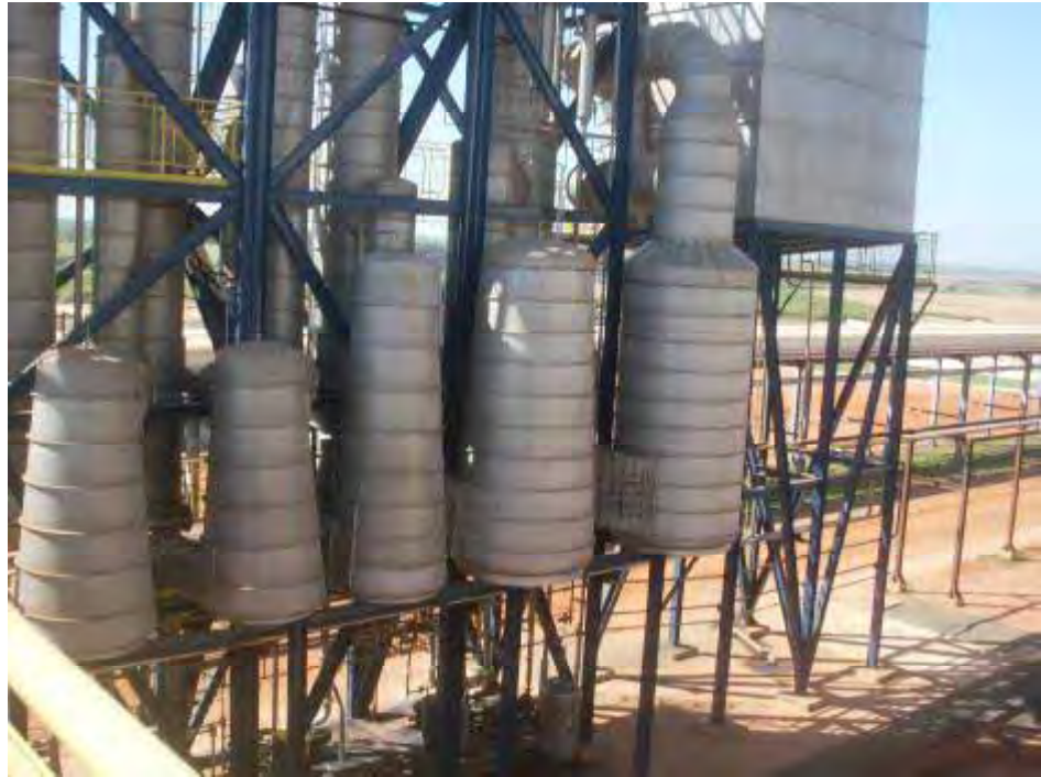
Figura 34 - Vista I da unidade de evaporação de vinhaça da Usina Cerradinho.
