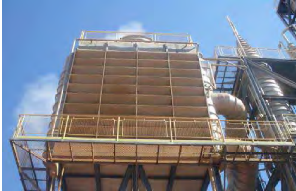
Figura 36 - Condensador evaporativo da unidade de evaporação de vinhaça da Usina Cerradinho.
