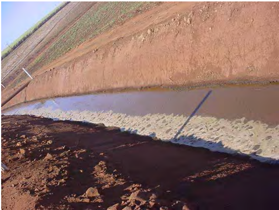
Figura 5 - Fotografia de canal condutor de vinhaça. Fonte: LIMONI (2008).
