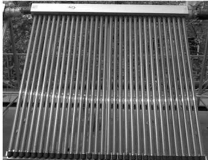
Figura 3: Coletor solar de tubos evacuados com circulação forçada. (LI ET AL., 2010)
