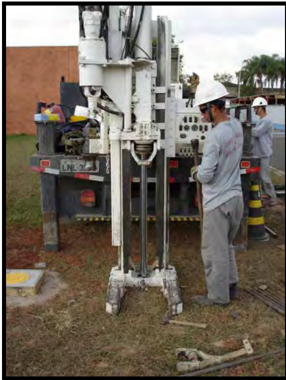
Foto 3 – Execução de amostragem contínua de solo com uso do Geoprobe.
