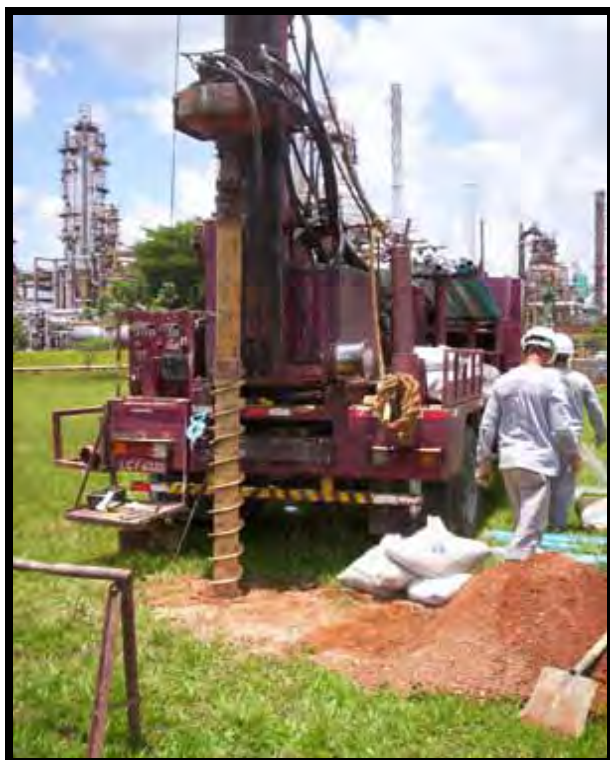
Foto 1 – Perfuração de sondagens com Hollow Stem Auger.
