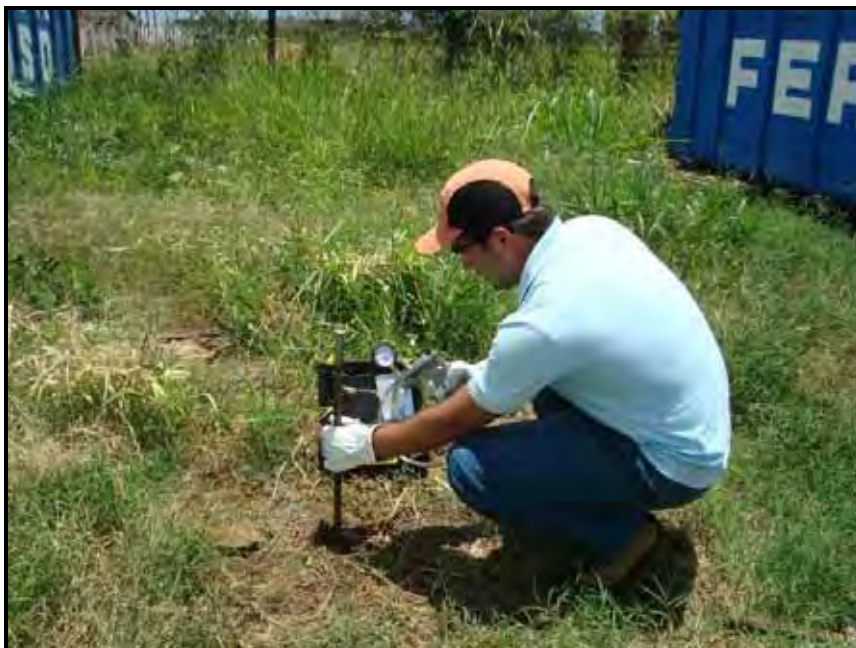
Figura 19 – Purga do sistema utilizando bomba de vácuo manual marca Mityvac .
