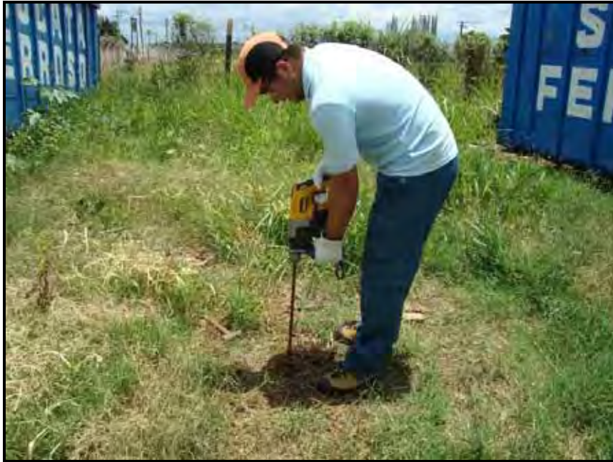
Figura 17 – Perfuração do solo com martetele roto-percussivo.
