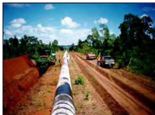
abertura de valas
