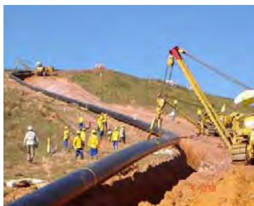
abaixamento da tubulação
