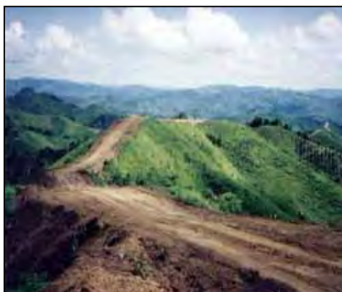
abertura de pista
