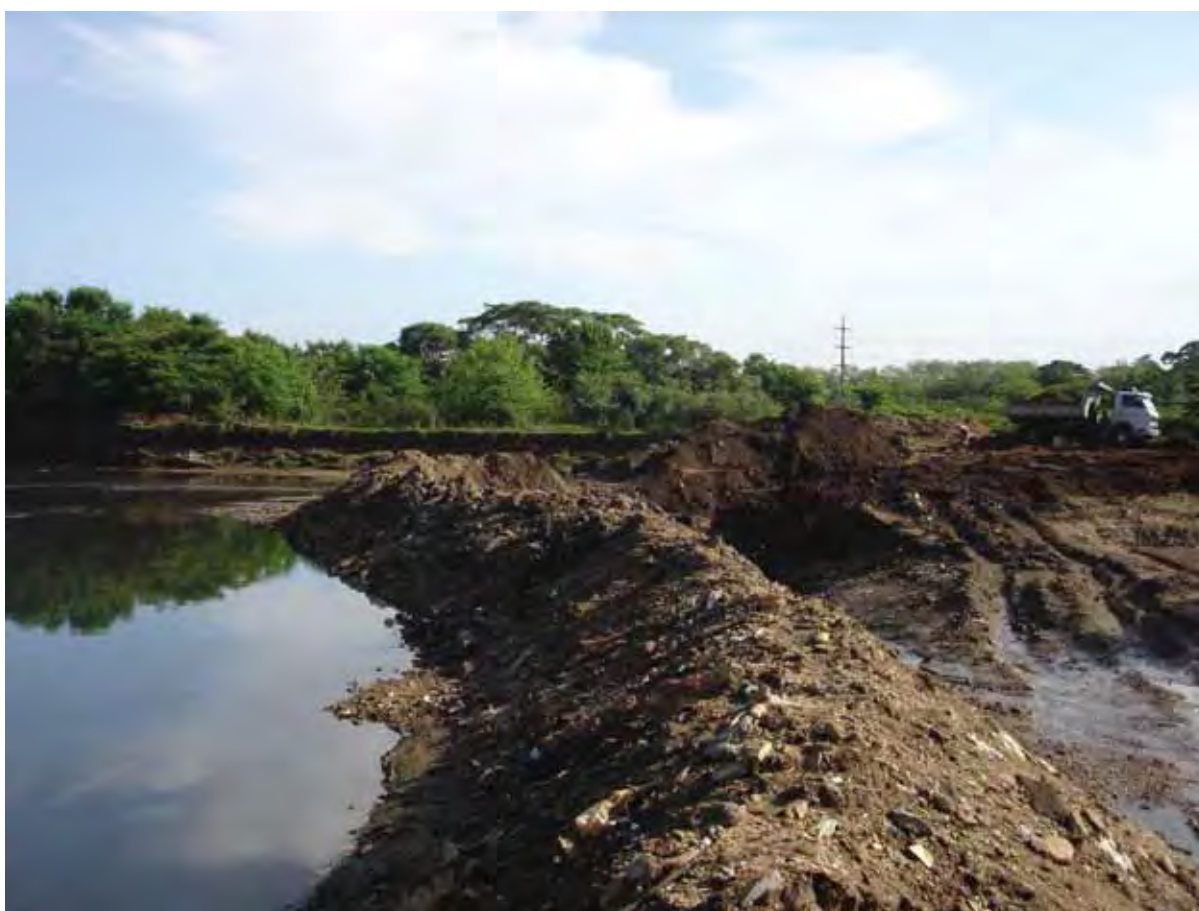
Figura 45. Dique marginal artificial recém construído na margem direita do ribeirão Anicuns, próximo à confluência com o córrego Botafogo, Goiânia - Goiás.
