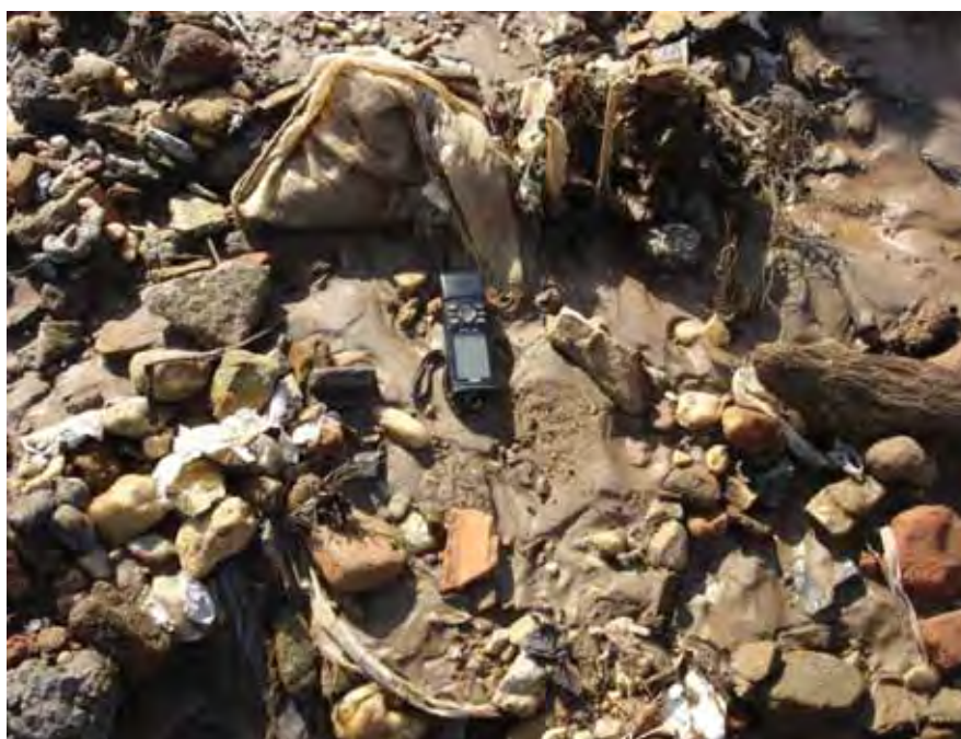
Figura 14. Registro de material constituinte de um dique marginal artificial.
