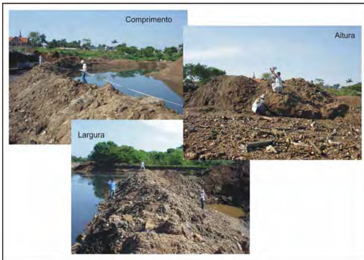
Figura 15. Registro das medidas de um dique marginal recém construído na margem direita do ribeirão Anicuns.
