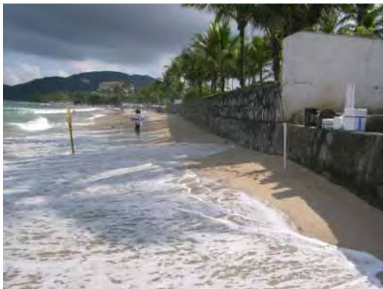
Figura 14 – Exemplo de estrutura artificial mapeada como segmento paralelo à linha de costa principal, na porção supralitoral da praia do Pernambuco. Foto tirada em maré alta.
