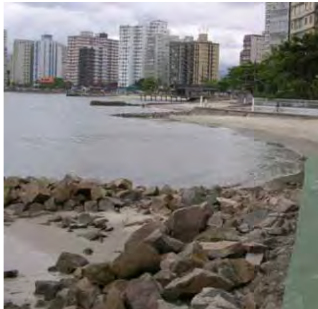
Figura 13 - Exemplos de estruturas construídas para tentar conter a erosão nas praias do setor sudeste da Baía de São Vicente.
