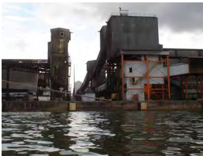
Figura 11 - Estrutura artificial no Porto de Santos. Muro de concreto, compacto, liso, de alta declividade, abrigado da ação direta das ondas (ISL 8).
