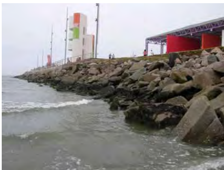
Figura 10 – Exemplo de estrutura artificial classificada com ISL 6. Píer/espigão de enrocamento sobre emissário submarino de Santos.
