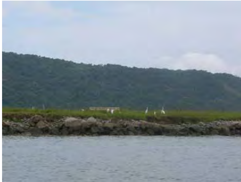
Figura 16 – Barranco arenoso (aterrado) vegetado com blocos rochosos na base, mapeado no Canal de Santos, município de Guarujá.
