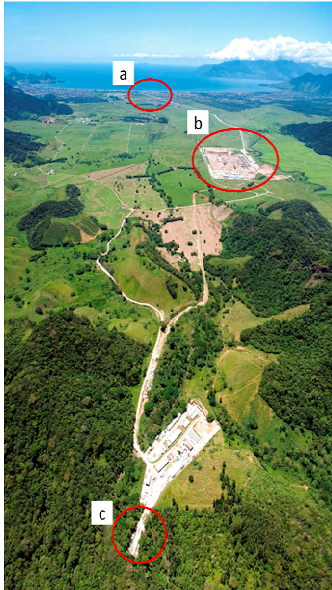
Figura 11: a) Chegada do duto marinho (Projeto Mexilhão); b) local onde foi instalada a UTGCA; c) início do trecho em túnel do GASTAU (adaptada de TEIXEIRA, LEGASPE, MILANELLI, 2011).
