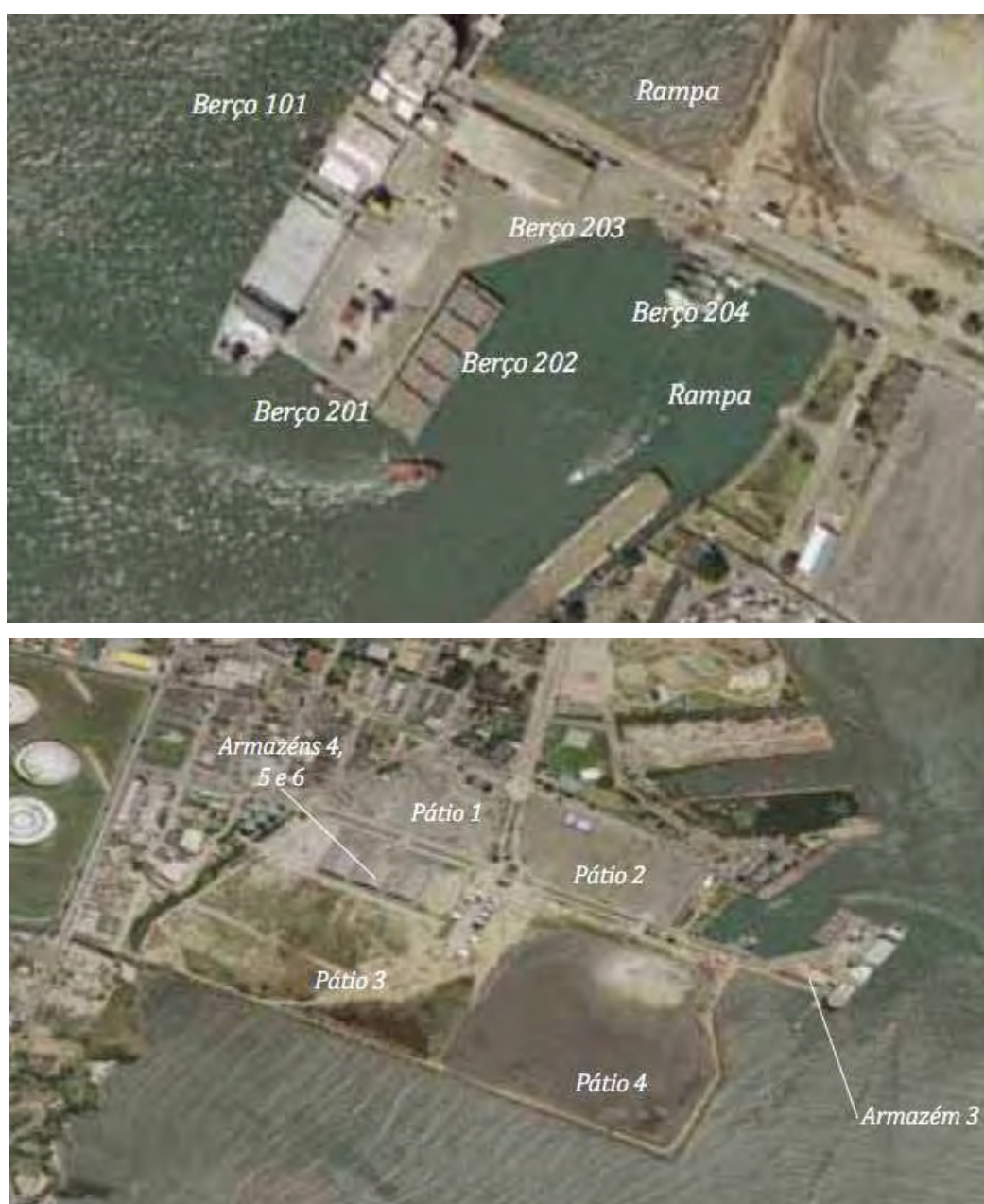
Figura 06: Berços de atracação (foto acima) e Instalações de Armazenagem (foto abaixo). (Adaptado de: CONSULTORIA..., 2011).
