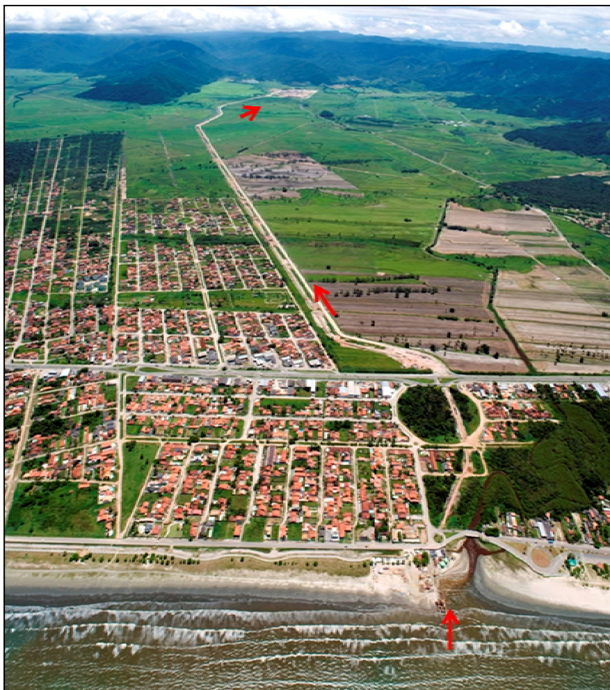
Figura 10: Chegada do duto marinho em Caraguatatuba e percurso do duto terrestre até a UTGCA (setas) (Adaptado de TEIXEIRA, LEGASPE, MILANELLI, 2011)
