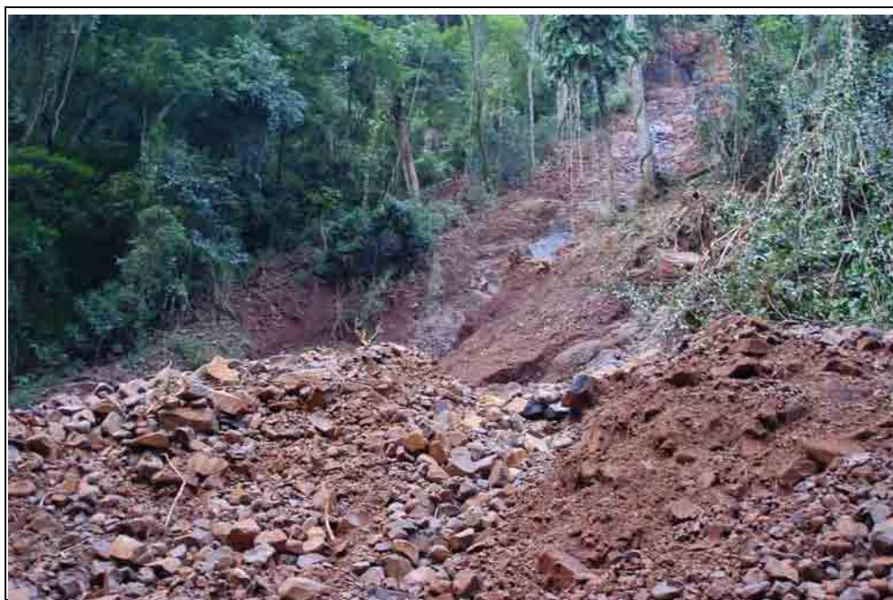
Foto 3 - Remoção de solo causada por erosão a montante.
