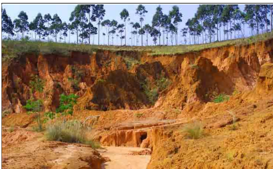
Foto 20 – Detalhe dos drenos construídos para contenção da voçoroca.
