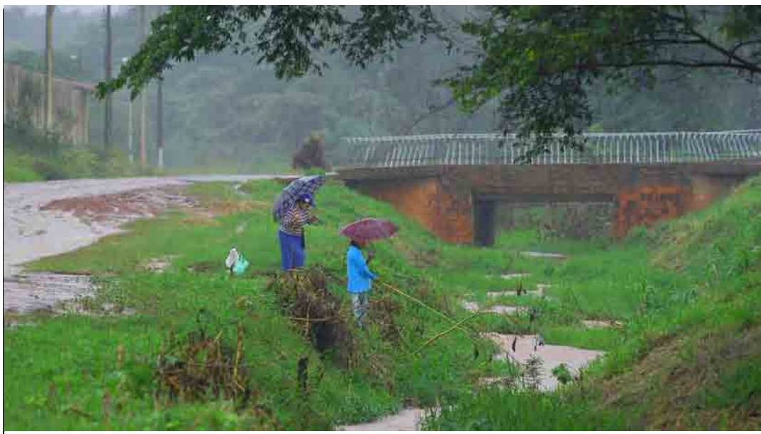
Foto 11 – Assoreamento no Córrego da Lagoa Seca (Brotas-SP).
