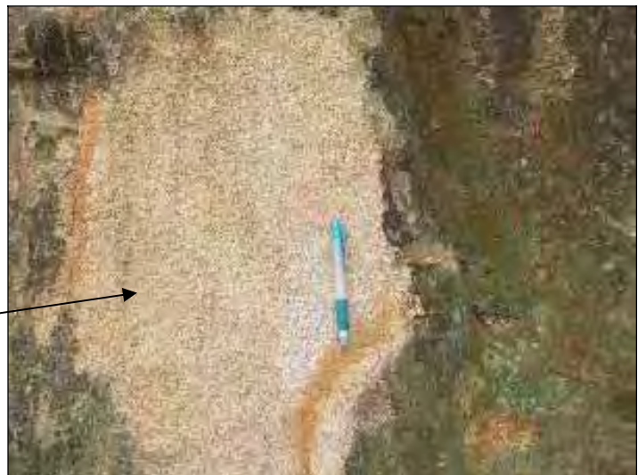
Figura 26: Detalhe de rochas graníticas alteradas. (Ponto 19).
