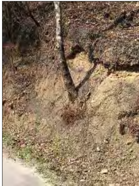
Figura 18: Vista de perfil de alteração com cobertura coluvionar. Nota-se que a árvore no centro da foto evidencia ocorrência de rastejo (Ponto 36).
