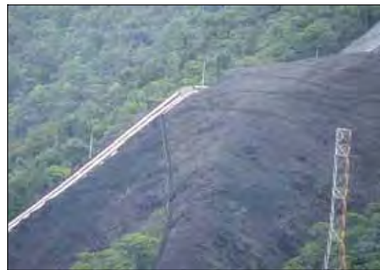
Figura 48: Detalhe do duto onde se observa que na faixa do duto não há vegetação, sendo o duto instalado sobre a superfície das rochas que estão cobertas por piche (material impermeabilizante).
