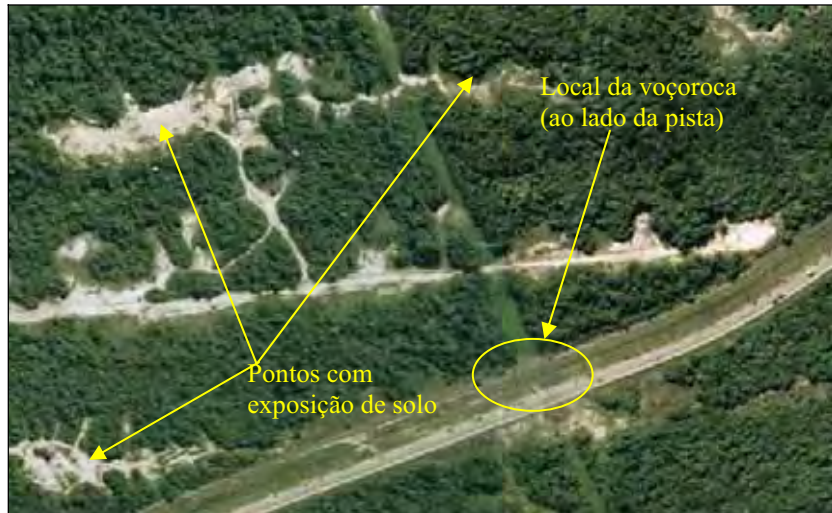
Figura 40: Vista, na ortofoto, da região onde são encontrados processos erosivos e exposição de solo.
