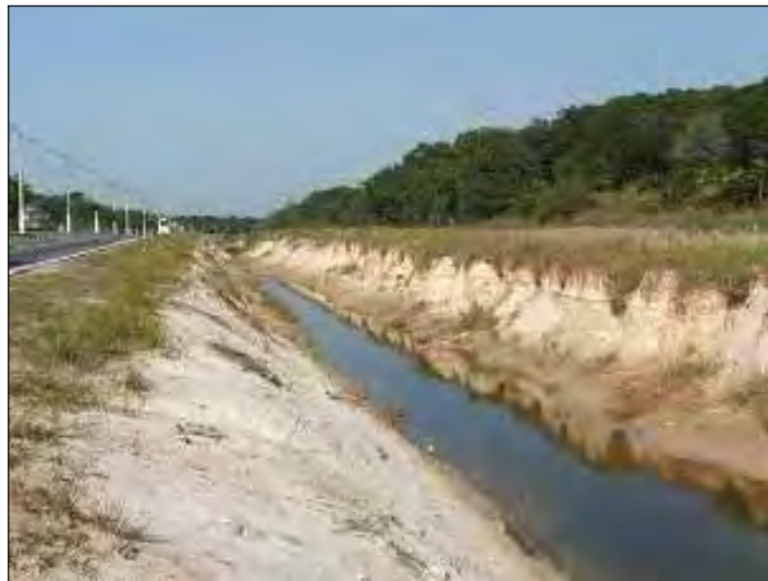
Figura 30: Vista geral dos depósitos arenosos pleistocênicos com presença de dreno instalado ao lado da pista que liga São Vicente ao Bairro Continental. (Ponto 37).
