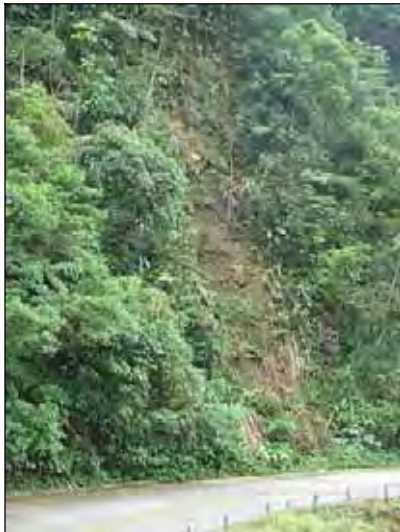
Figura 43: Detalhe de escorregamento ocorrido no talude da estrada Caminho do Mar.
