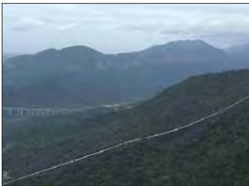
Figura 47: Vista do duto instalado sobre o espigão da encosta da Serra do Mar
