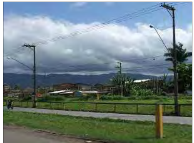
Figura 39: Vista parcial da estrada (rod. Anchieta – sentido capital) sobre mangue que foi desmatado e aterrado. As estacas amarelas marcam posicionamento dos oleodutos.
