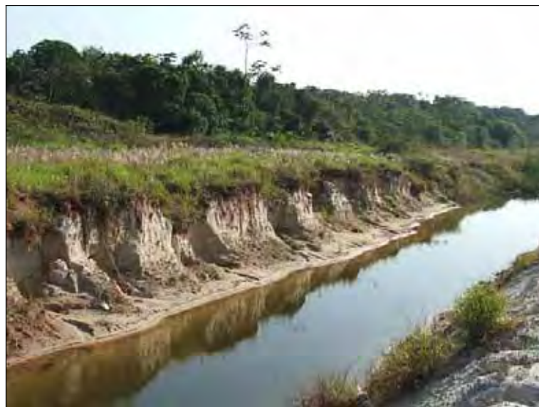
Figura 41: Detalhe de canal que foi aberto onde são encontradas pequenas erosões nas laterais deste canal ao lado da pista (ponto indicado pela seta – Ponto 37).
