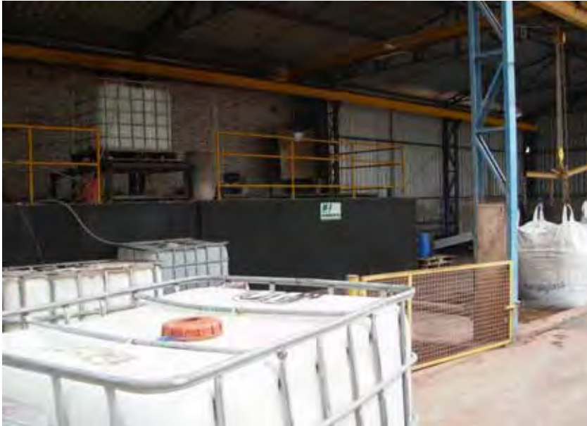
Figura 34 - Estação de tratamento de efluente da cerâmica.
