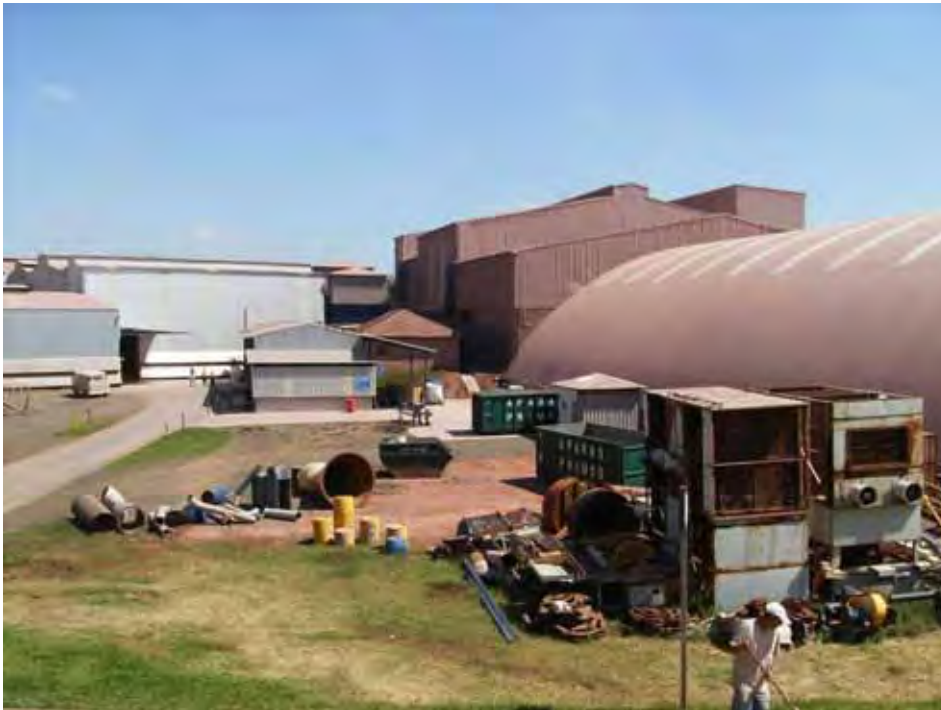
Figura 24- Área externa da cerâmica, no estágio de limpeza dos entulhos e construção da cobertura.
