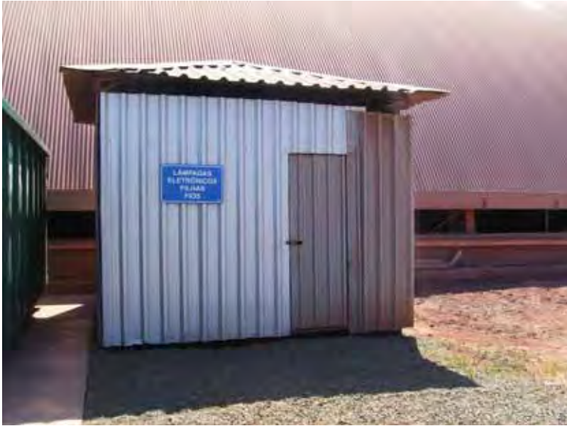
Figura 26 - Sala para armazenamento de resíduos com valor comercial alto.
