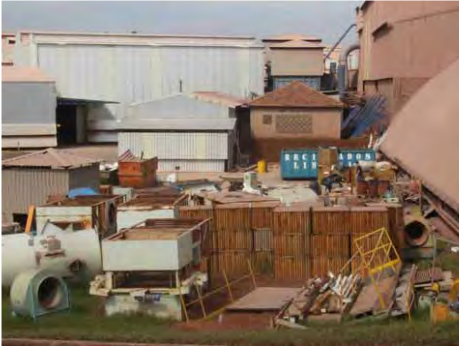
Figura 18 - Área externa da cerâmica antes da limpeza da área externa.
