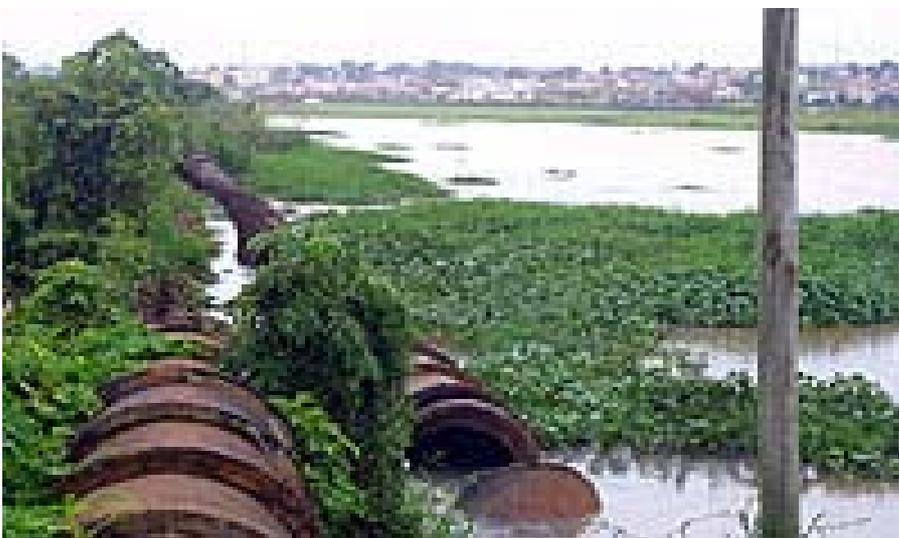
**Foto 49: VAZAMENTO DE ESGOTO EM EMISSÁRIO QUE ATINGE O RIO PRETO**
