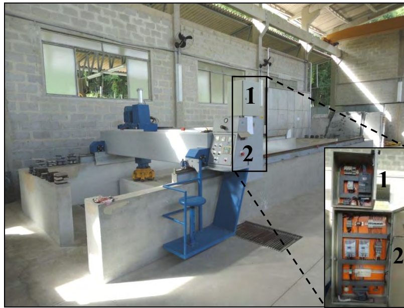
Legenda: 1 - Inversor de frequência instalado; 2 - painel elétrico original da politriz. Fonte: Elaborada pelo autor.
