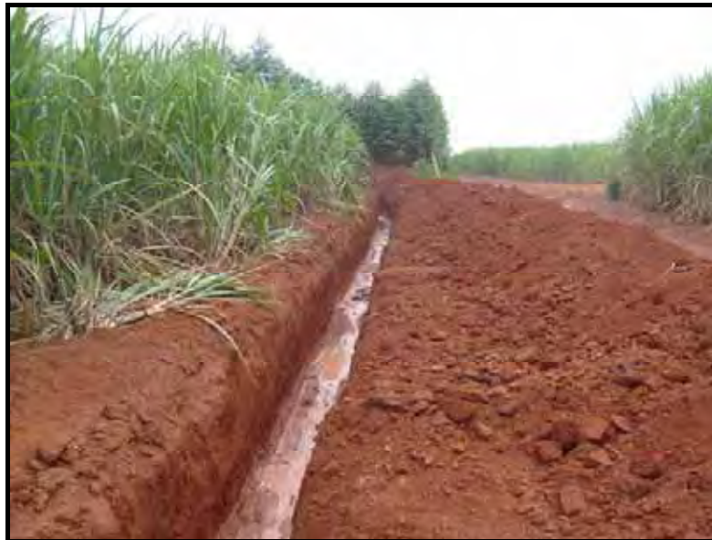
Figura 4.6 – Obras de engenharia que drenam água da antiga cava de mineração para um curso de água localizado vertente abaixo, evitando um aumento nos processos de erosão linear.
