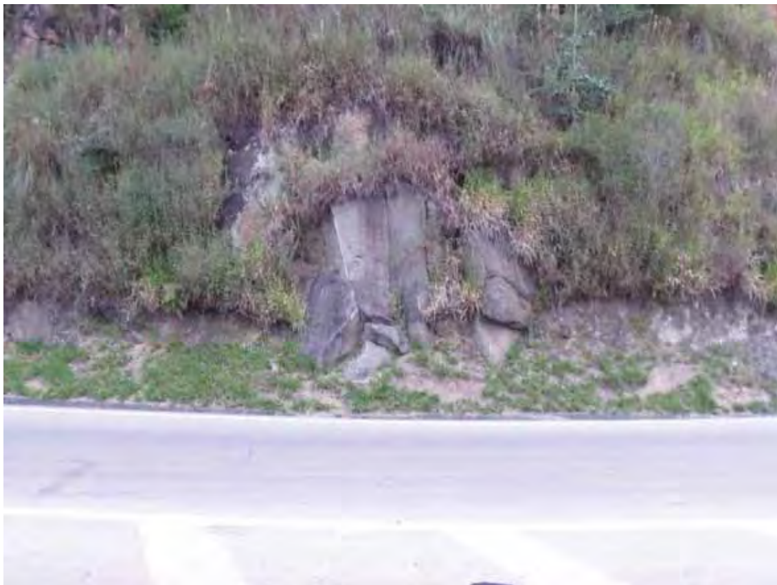
Figura 7_11 – Afloramento de Granito com um bloco restrito por fraturas subhorizontais e subverticais.
