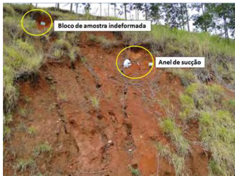
Figura 56 – Localização das coletas de amostras indeformadas no talude 2.
