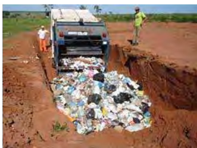
Figura 83 – Resíduos sendo depositado nas valas do aterro de Cabrália Paulista.
