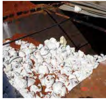
Figura 56 – Construção de vala séptica e disposição dos RSS em vala previamente preparada no aterro sanitário de Bauru. Fonte: LOPES, 2007.
