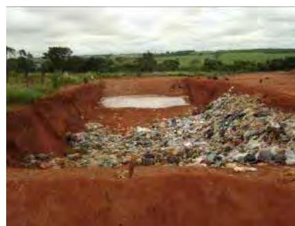
Figura 91 – Visão geral do aterro de Duartina e detalhe da vala onde estão sendo depositados os resíduos.
