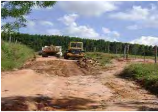
Figura 04 – Caminhões despejando “entulho” em estrada municipal.
