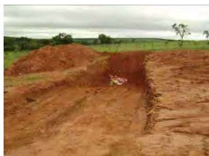
Figura 83 – Resíduos sendo depositado nas valas do aterro de Cabrália Paulista.
