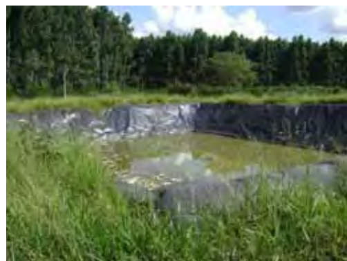
Figura 06 – Lagoa de chorume do aterro.
