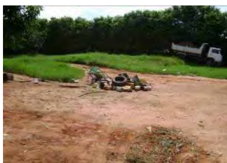
Figura 114 – Detalhe dos objetos deixados à céu aberto no aterro sanitário.
