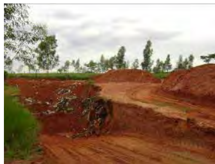
Figura 32 – Detalhe da vala onde estão sendo depositados os resíduos.
