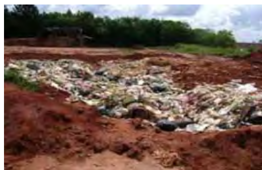
Figura 23 – Aspecto geral do aterro e detalhe da vala aberta.
