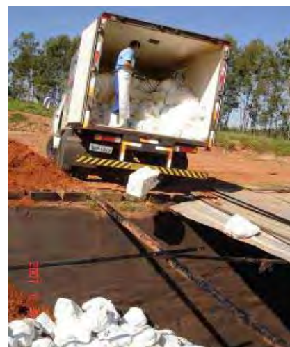
Figura 51 - Disposição dos RSS em valas sépticas no aterro sanitário do município de Bauru.
