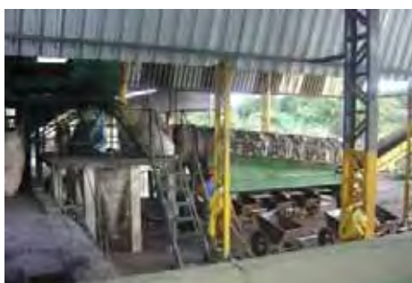
Figura 128 – Vista geral da peneira para os resíduos orgânicos que serão transformados em composto orgânico.
