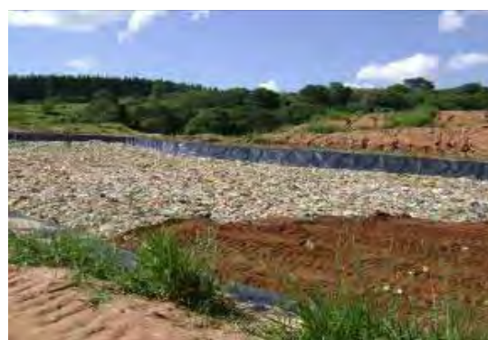
Figura 10 – Visão da única vala do aterro sendo coberta com terra.
