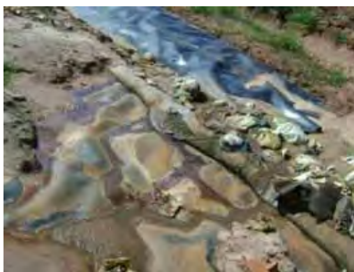
Figura 07 – Extremidade da manta de impermeabilização.
