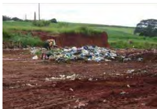
Figura 66 – Visão do aterro de Boracéia mostrando a presença de catadores e animais no resíduo descoberto.
