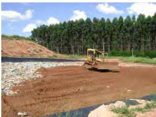
Figura 05 – Trator cobrindo vala do aterro.
