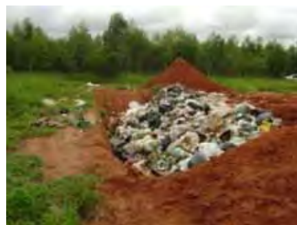
Figura 96 – Vala aberta preparada para ser coberta.
