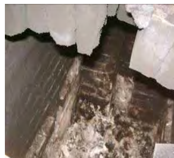
Figura 20 – Detalhe do interior do forno.
