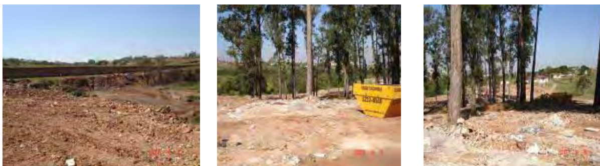
Figura 49 – Bolsão de entulho cadastrado pela SEMMA, Bauru. Fonte: LOPES, 2007.
