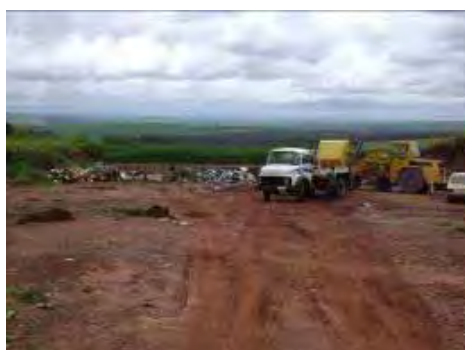
Figura 65 – Visão geral do aterro de Boracéia.
