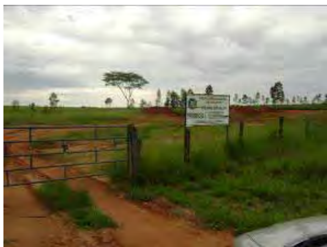
Figura 31 – Entrada da área do aterro.
