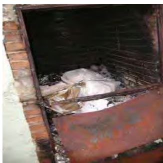
Figura 62 – Forno, localizado no Centro de Saúde, onde são “incinerados” os RSS de Boracéia.
