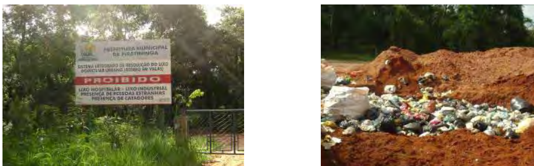
Figura 165 – Portão de entrada e visão geral do aterro de Piratininga.
