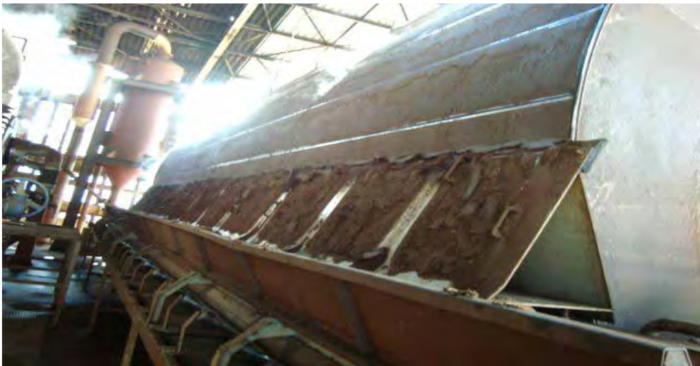
Figura 20 - Fotografia de um filtro contínuo de tambor rotativo a vácuo tamanho 4.270 mm de diâmetro por x 12.190 mm de comprimento (14'x 40'). Fonte: Usina (2008).
