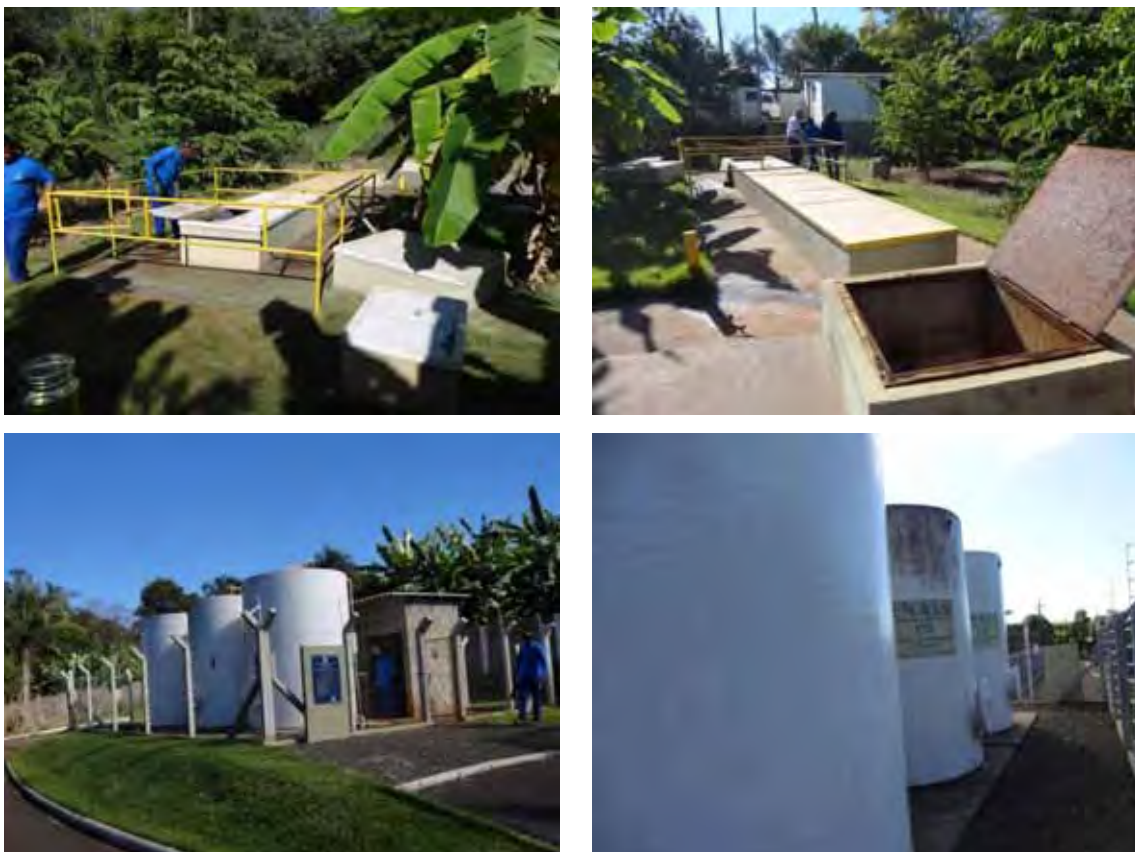
Figura 55 – Estação de Tratamento de Esgotos(ETE) do Serviço Autônomo de Água e Esgotos (SAAE), localizada no distrito de Alfredo Guedes, município de Lençóis Paulista.
