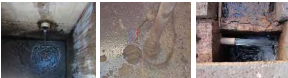
Figura 56 – Recepção do esgoto, formação do lodo e saída dos efluentes tratados.
