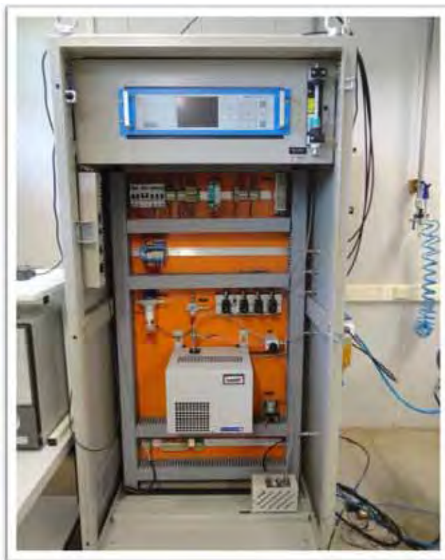
Figura 28 – Analisador de gases, modelo S710, fabricado pela empresa Sick Maihak.
