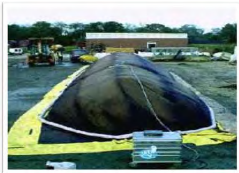
Figura 13 - Compostagem através do sistema de leiras estáticas aeradas ( static pile ).
