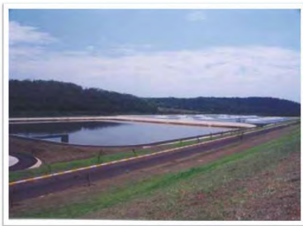
Figura 39 – Estação de Tratamento de Esgotos “Manoel Ferreira Leão Neto” do Departamento Autônomo de Águas e Esgotos (DAAE) Araraquara-SP.
