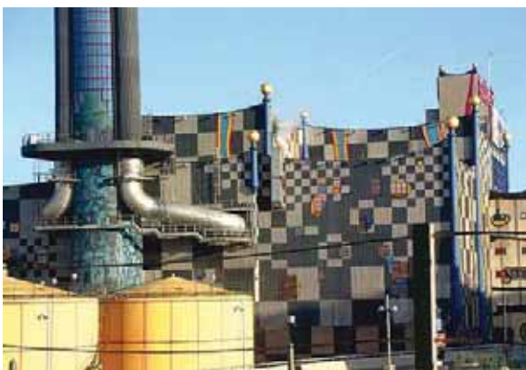
Figura 11: Usina de incineração de resíduos domésticos, Viena, Áustria. Fonte: Pita, 2012.
