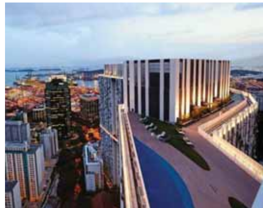
Figura 14 – Skybridge Pinnacle Duxton, Cingapura. Fonte: www.pinnacleduxton.com.sg
