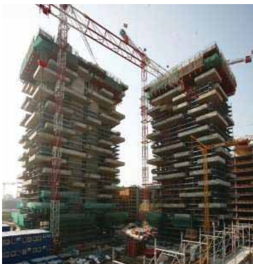
Figura 6 – Construção do Edifício Bosco Verticales. Fonte: Boeri Studio, 2012.
