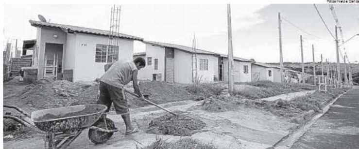
O Moradas do Buriti foi entregue há apenas 60 dias e já virou um enorme canteiro de obras, a maior parte para instalação de muros
