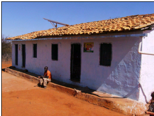
Fotografias 23 e 24: Casas de Quenta Sol, construídas com adobe e pau. Fonte: Dados da pesquisa, 26 de julho de 2008.
