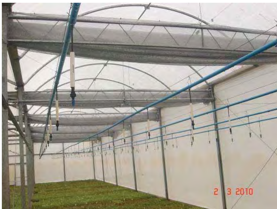
Figura 3. Sistema de irrigação por aspersão instalado na casa de vegetação, Bofete – SP, 2010.
