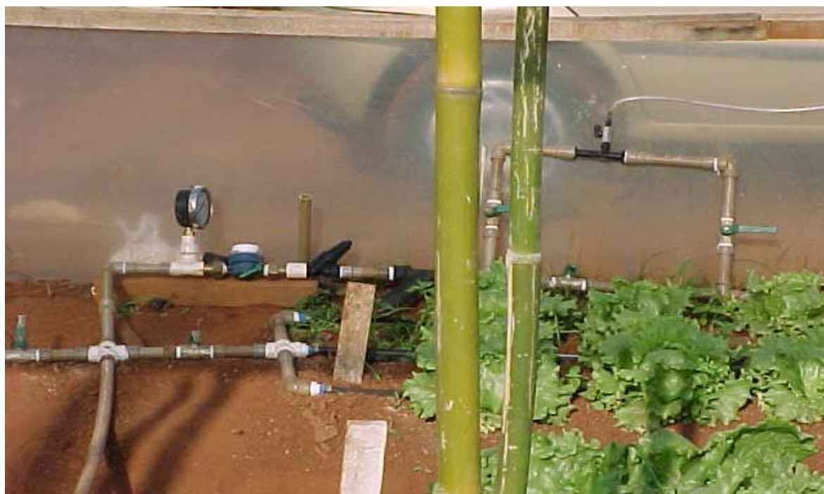
Figura 2. Detalhe do cavalete e linha lateral de irrigação em uma das estufas.
