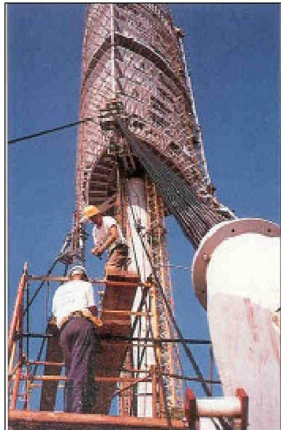
Figura 2. 4: Torre de Comunicação de Barcelona com 268m de altura. (HELENE 2002).
