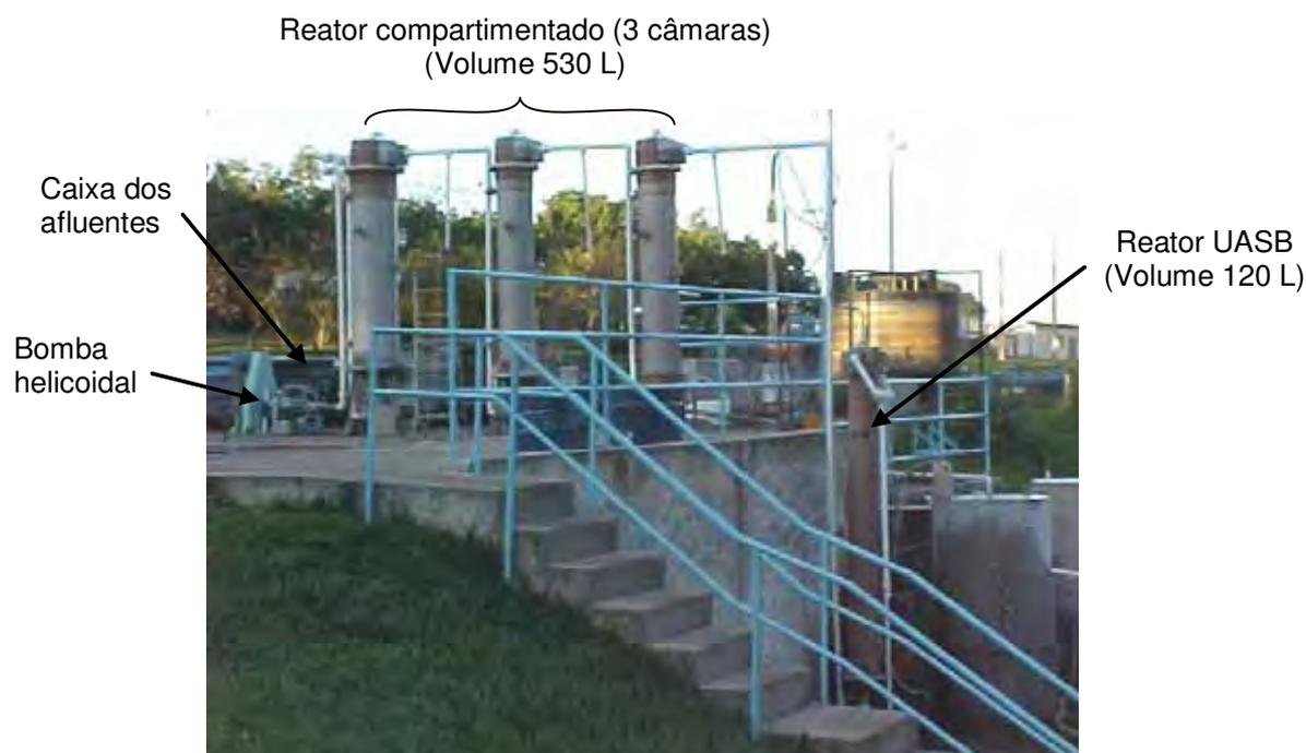
FIGURA 3. Instalações experimentais compostas por reator de chicanas seguido de reator UASB.
