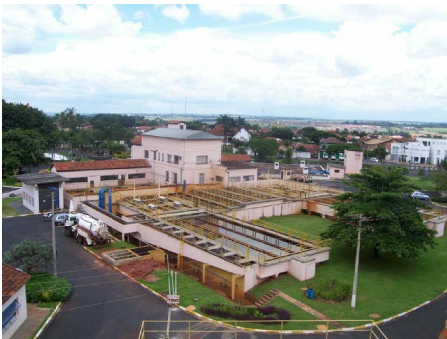
Figura 3.1. Vista da Estação de Tratamento de Água – ETA Fonte.
