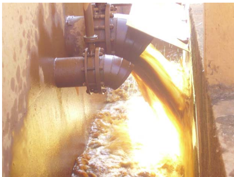
Figura 3.2. Conjunto de válvulas utilizadas para descarga do decantador.
