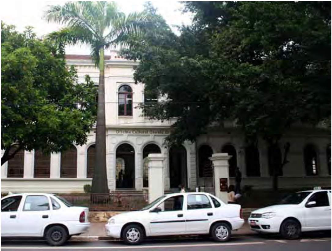
Figura 1 – Prédio da Rua Três Rios, 363
