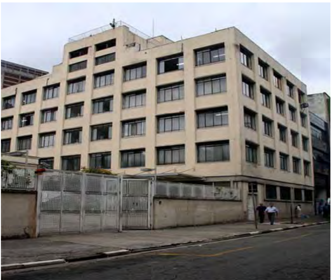
Figura 2 – Prédio Anexo, Rua Lubavitch, 64
