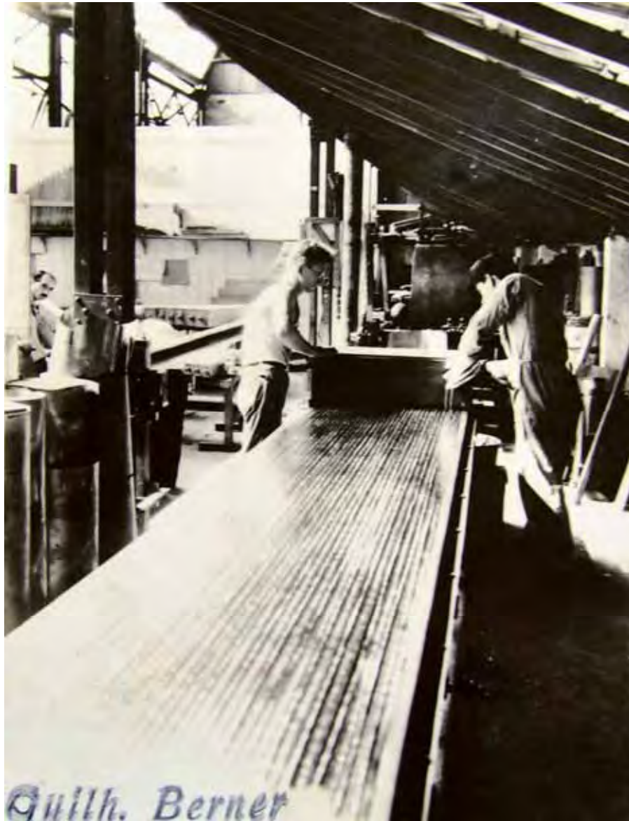
Figura 46: Interior da fábrica – fundição das chapas dos tubos de metal
