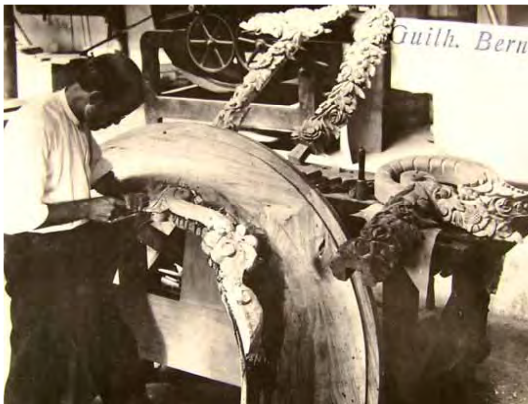
Figura 50: Interior da fábrica – marcenaria
