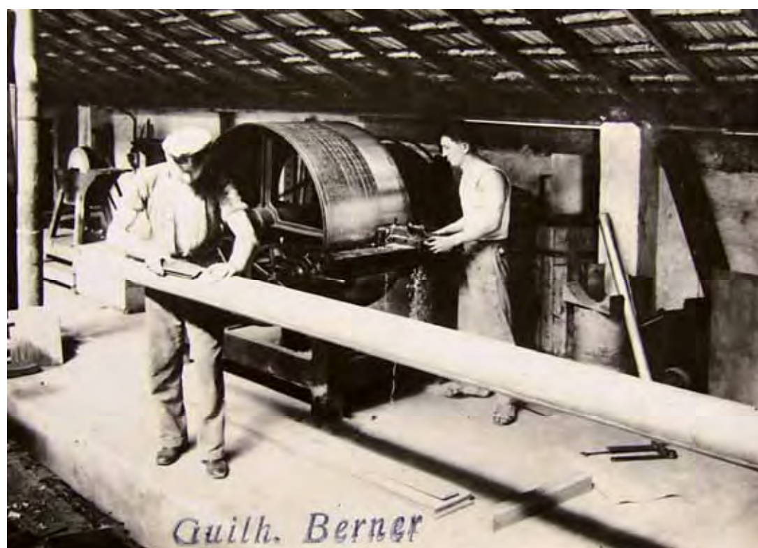
Figura 45: Interior da fábrica – fabricação dos tubos de metal
