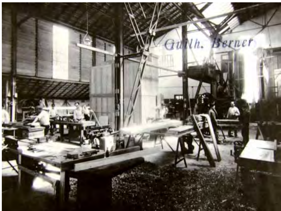
Figura 44: Interior da fábrica
