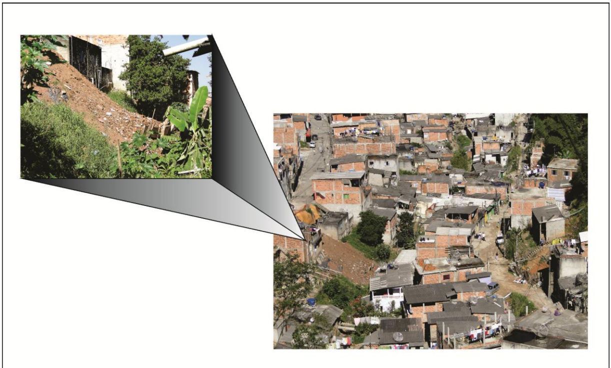
Figura 39: Execução de patamares (“aterros lançados”) gerados pela deposição do próprio material de escavação dos cortes.
