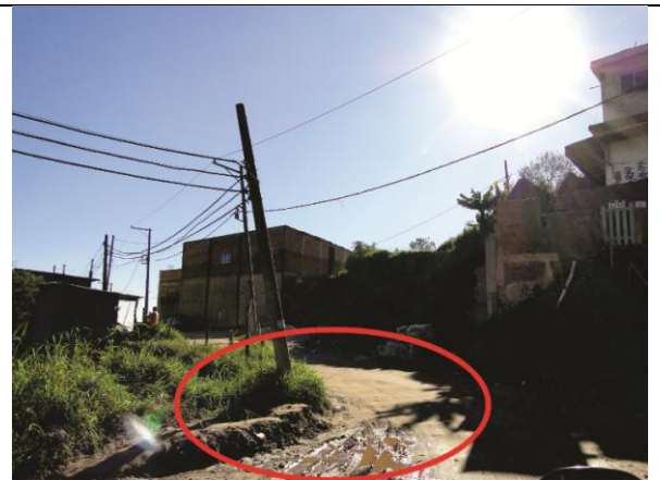
Foto 47: Poste inclinado. Reparar na presença de concentração de água na via Fonte: Rodrigo Pucci da Conceição
