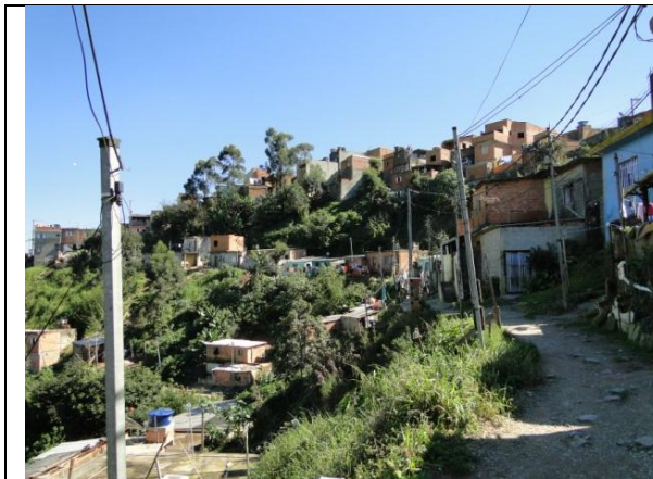
Foto 46: Poste inclinado, com arruamento apresentando processo erosivo Fonte: Rodrigo Pucci da Conceição
