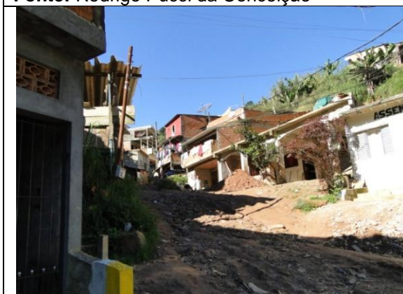
Foto 27: Via sem pavimentação, com processo erosivo e sem iluminação
