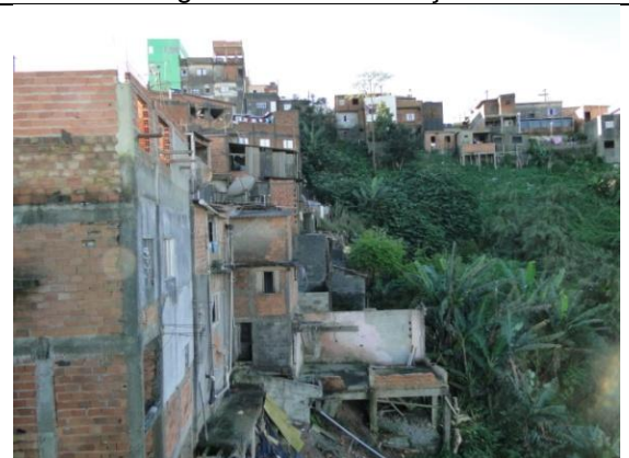
Foto 24: Residências de baixo padrão e altos cortes de talude vizinhas a casa visualizada na foto 23 Fonte: Rodrigo Pucci da Conceição
