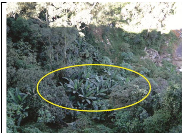
Foto 38: Presença de bananeiras ao longo do talude.
