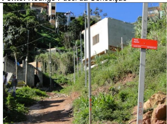
Foto 28: Viela sem pavimentação, sem iluminação e em péssimas condições
