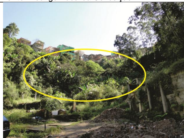
Foto 41: Presença de bananeiras ao longo do talude.
