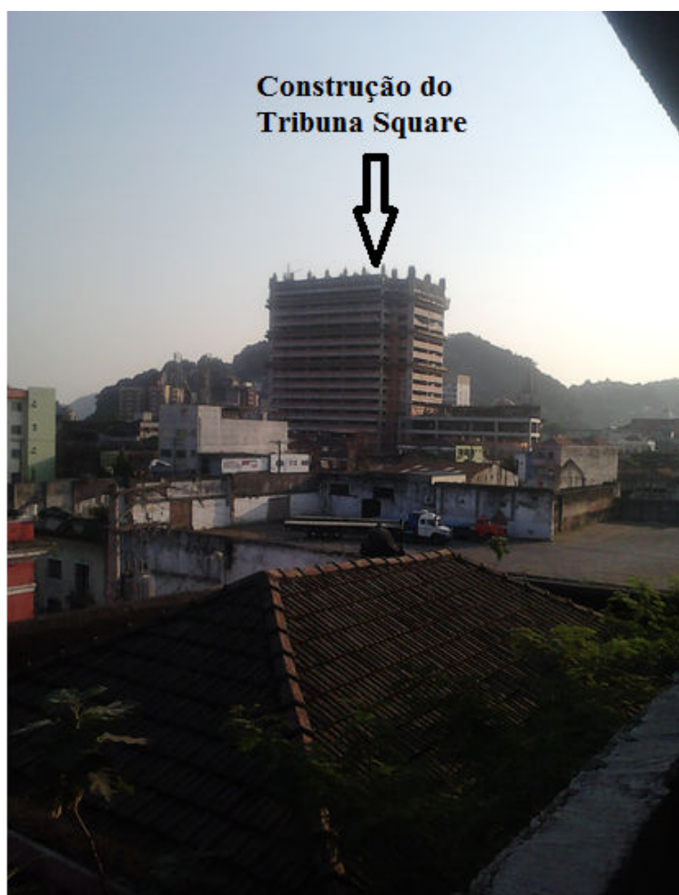
Foto 10 - Vista da construção do prédio Tribuna Square em maio de 2013
