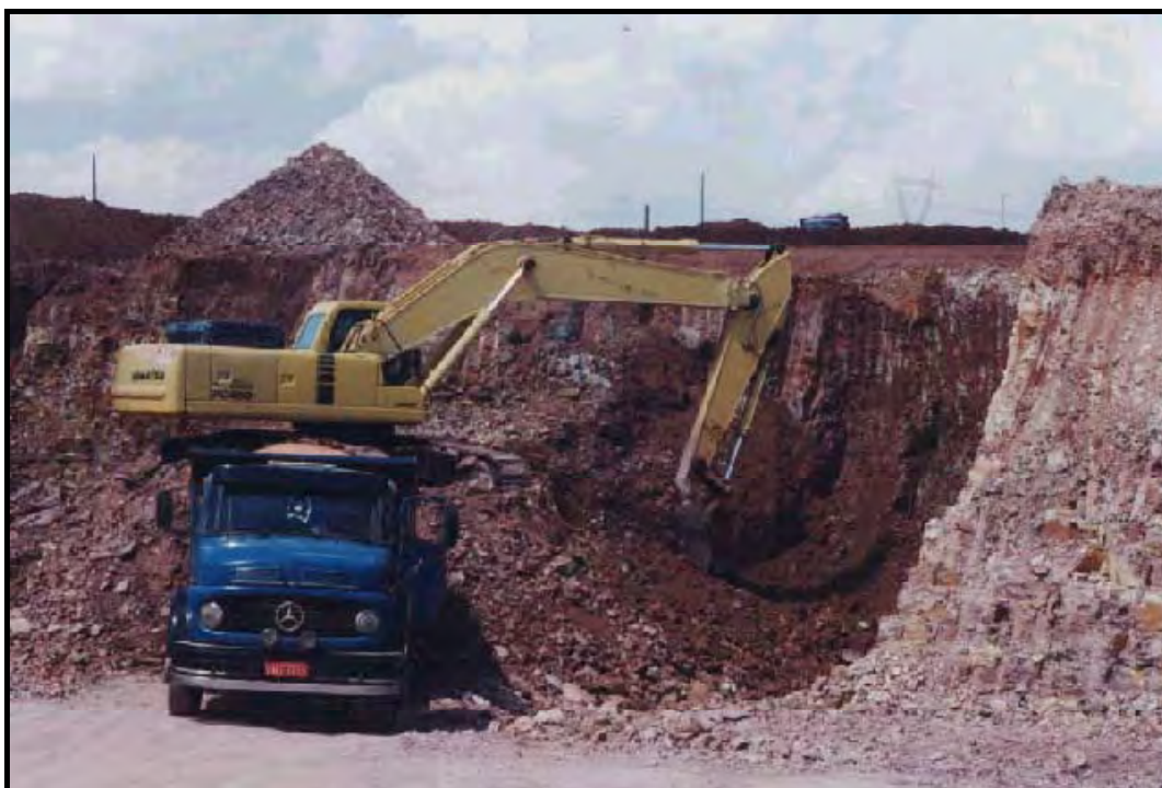
Foto 05: Cava de argila em atividade.
