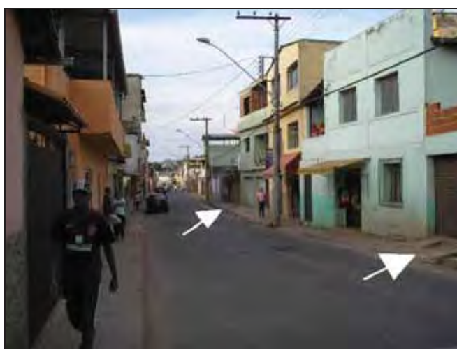
Figura 42 - Degraus provocados por rampas de garagem, na Rua da Conceição.
