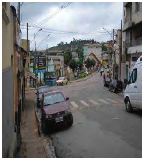
Figura 47 - Estreitamento na Rua dos Passos – não há um alinhamento preciso dos meios-fios ao longo da via, fazendo com ela mude de largura constantemente.
