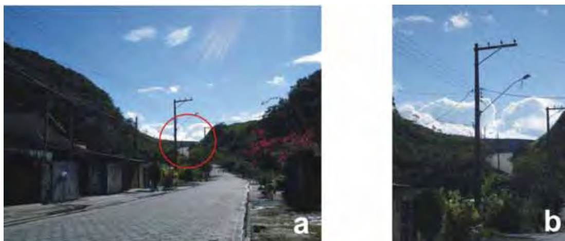
Fotos 6a e b – Reservatório da SABESP situado no Morro do Melico.
