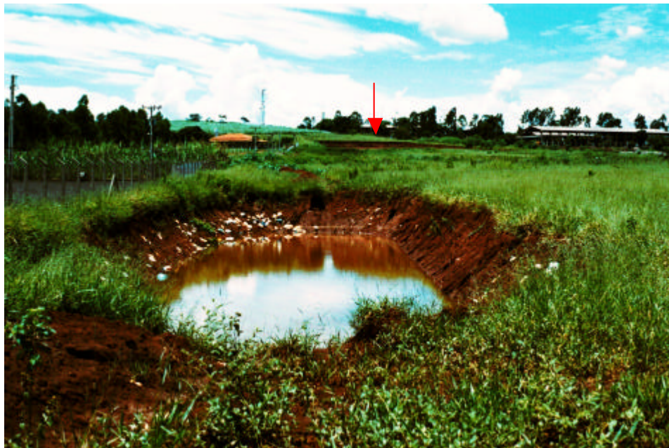
Figura 8 – “Piscinão” construído na área do Lixão de Serrana para captação das águas pluviais. Ao fundo, a área de deposição de lixo. (Foto do autor).
