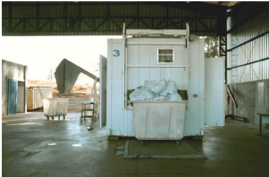
Figura 3 - Forno de microondas instalado no aterro sanitário de Ribeirão Preto. O primeiro contêiner mostra a entrada dos resíduos (por elevação), o segundo recebe os resíduos já triturados e desinfetados. Ao fundo uma caçamba armazena os resíduos até que sejam enviados para aterramento. (Foto do autor).
