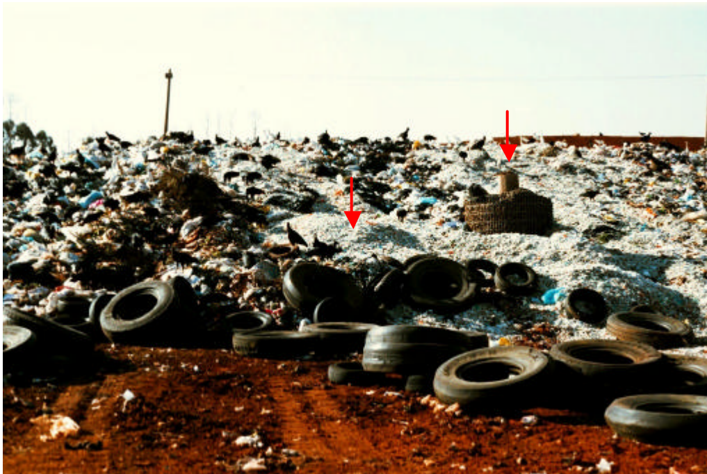
Figura 10 – Detalhe da célula de recebimento de lixo no aterro de Ribeirão Preto. As setas estão indicando o dreno para captação de gases e os resíduos de saúde que são ali depositados, depois de triturados e tratados por microondas. Observa-se, ainda, uma grande quantidade de pneus inservíveis. (foto do autor).
