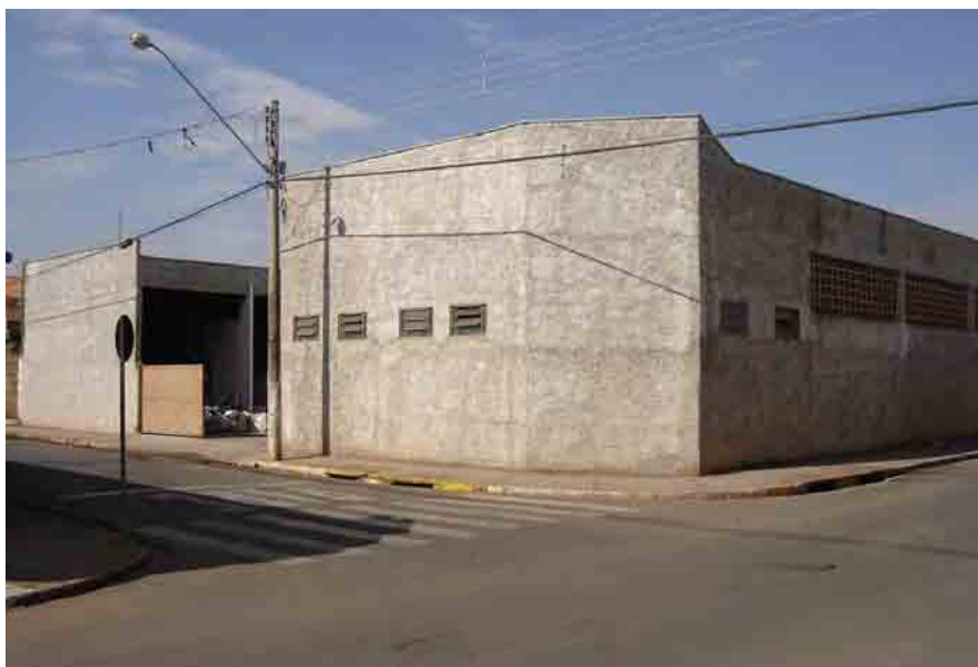
Figura 5.6. Fachada da central de triagem.
