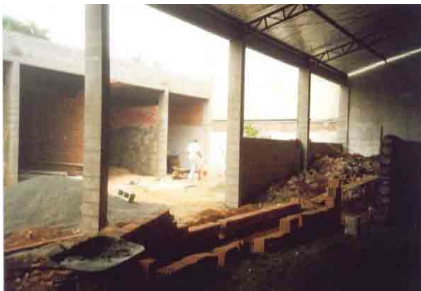
Figura 5.7. Interior da central de triagem, durante sua construção.
