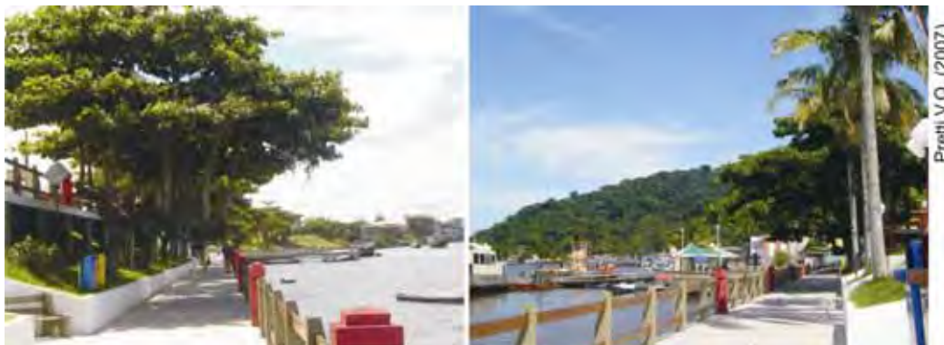
Foto 6: Píer Municipal, após a reforma.
