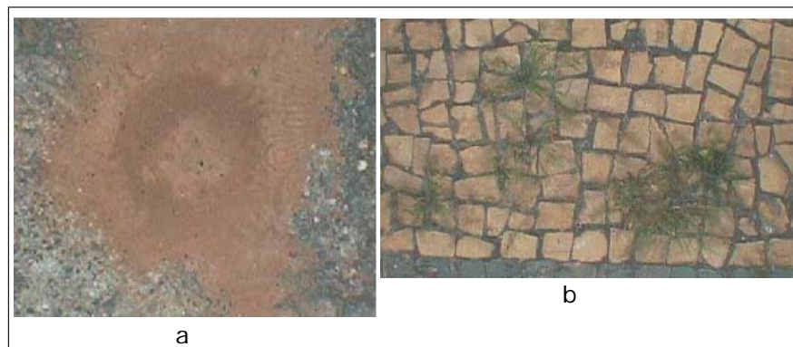
Figura 6: Ação das formigas e da vegetação na calçada
