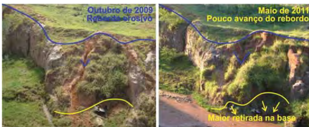
Fig. 33a e 33b – Setor do talude erosivo com pouco recuo da linha de rebordo.
