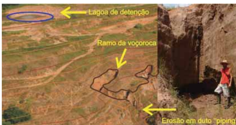
Fig. 25 – Correspondência topográfica entre área de infiltração e ocorrência de piping.
