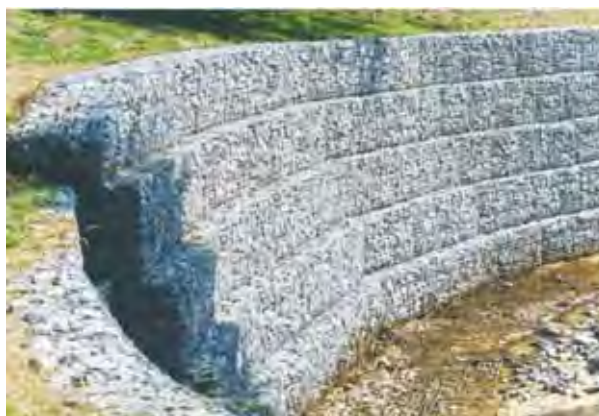
Fig. 43 – Gabiões em caixa dispostos em forma de anfiteatro.
