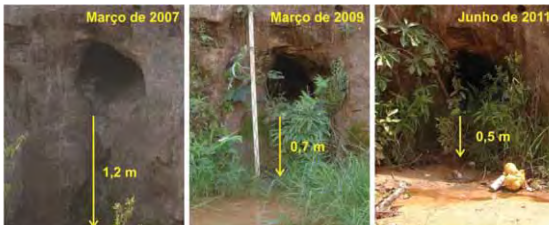
Fig. 35a, 35b e 35c – Ascensão do fundo da voçoroca pelo acúmulo de sedimentos.
