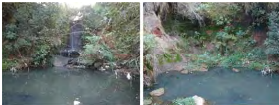
Fig. 30a e 30b - Ponto de deságüe do emissário da Rede Sul com formação de lagoa e solapamento das margens, respectivamente.
