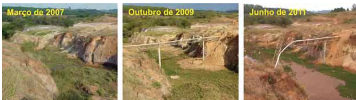
Fig. 36a, 36b e 36c – Porção da baixa bacia no ano de 2007 e após as obras de transposição da rede de esgoto sobre o canal erosivo entre os anos de 2009 e 2011, respectivamente.
