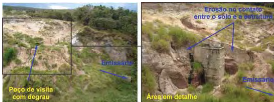
Fig. 31a e 31b - Poço de visita localizado a poucos metros de emissário no ano de 2007 e colapso dos solos no contato com a mesma no ano de 2010, respectivamente.
