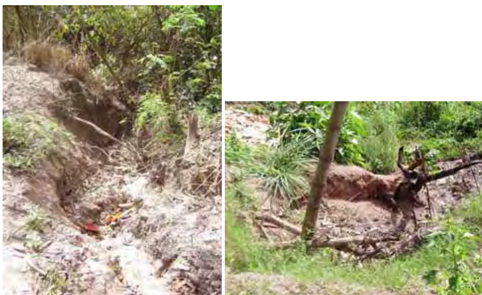
Fotos 23 e 24 – Feições Erosivas encontradas nas margens das ruas sem pavimentação do bairro do Alam Grei.
