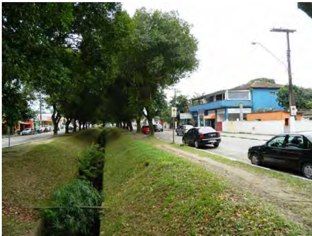
Figura 15: Unidade Terraços Marinhos Urbanizados, com a presença de estruturas urbanas e canais de drenagem retinizados.
