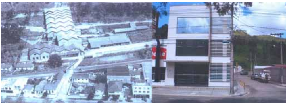
Figura 16 – Refuncionalização da unidade produtiva da CGM, nas proximidades da Av. João Pinheiro, 2012.
