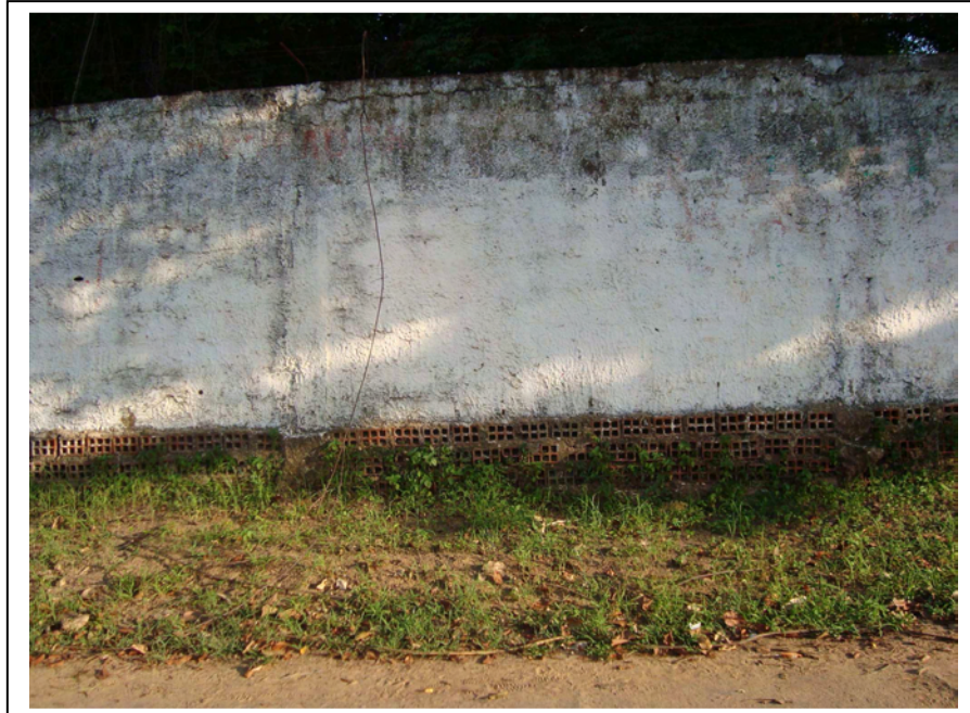
Figura 19 – Furos nos tijolos do baldrame do muro do Parque por onde passam as cobras.
