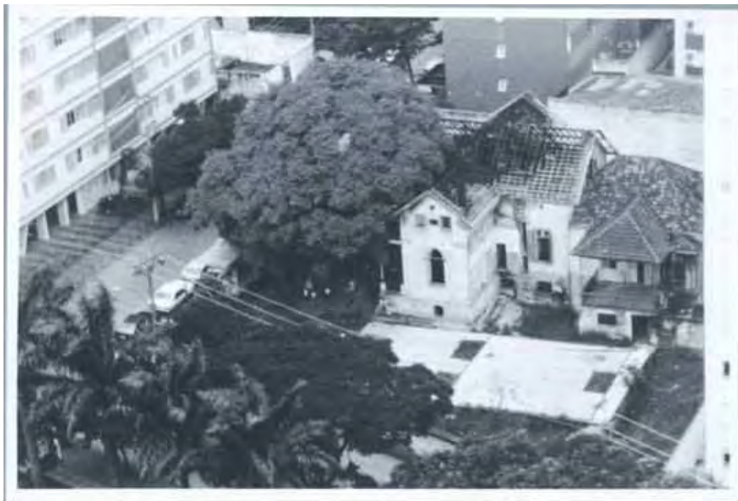
Figura 30 – Estado precário do Chalé, datada do final da década de 1980.
