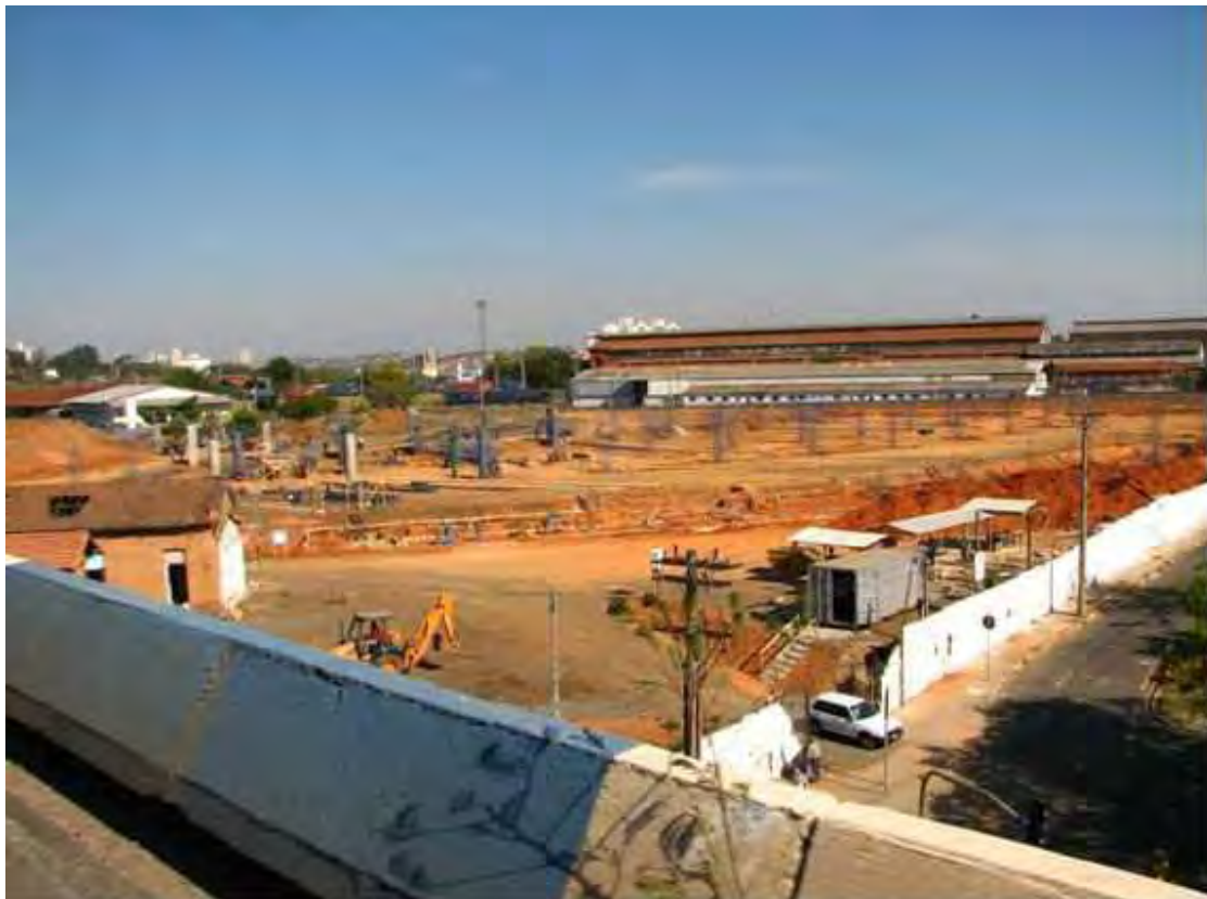
Figura 33 – Construção do Novo Terminal Rodoviário, em área do Complexo Ferroviário.
