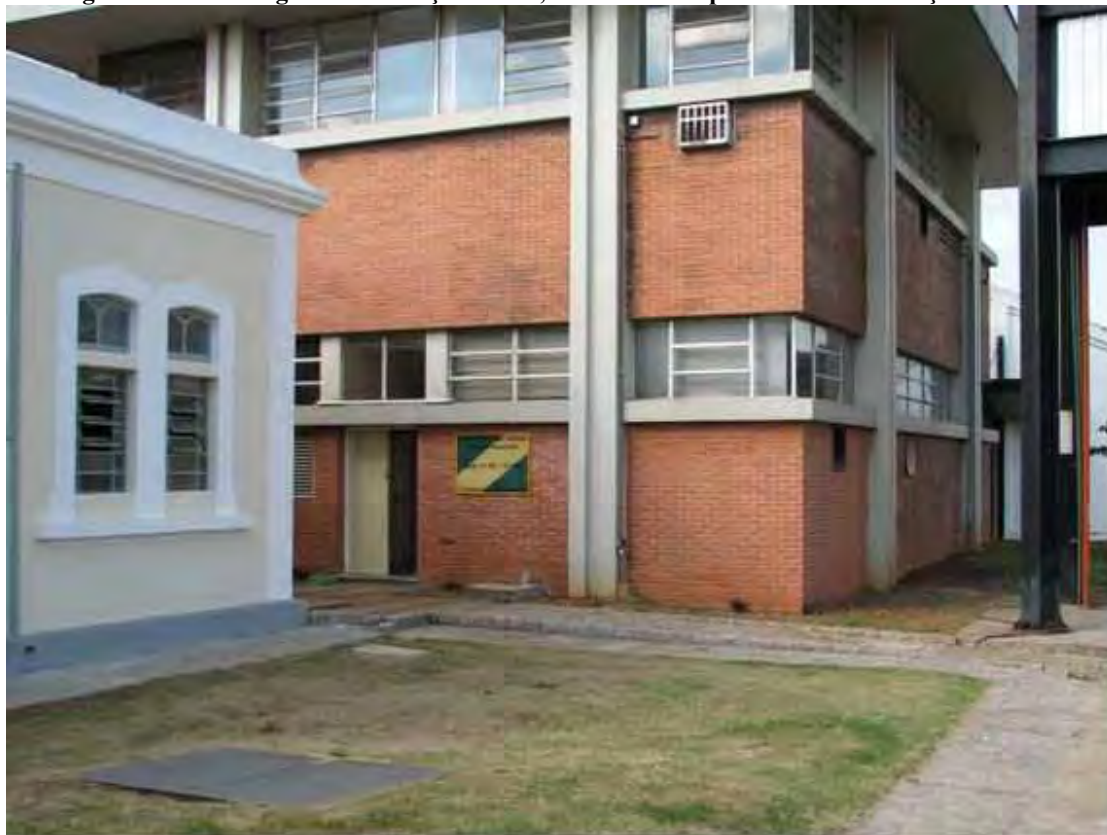
Figura 17 – 4ª Delegacia de Serviço Militar, localizada em prédio anexo à Estação Cultural.
