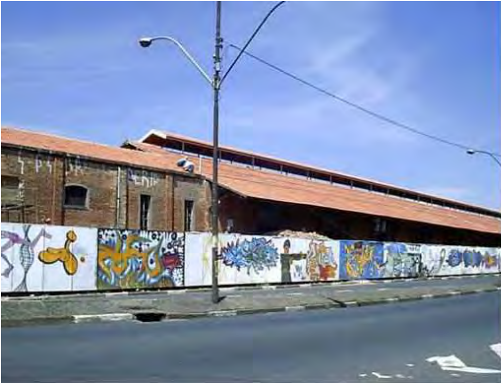
Figura 15 – Construção do CEPROCAMP.
