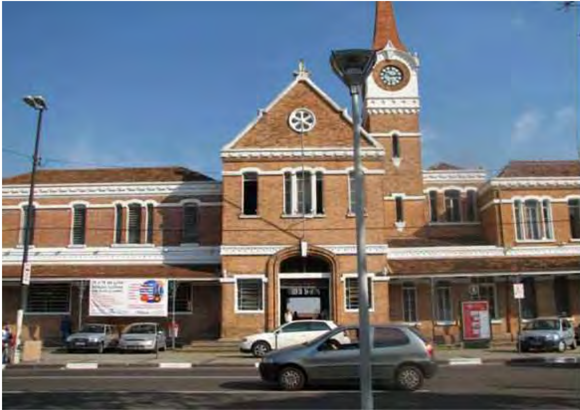
Figura 10 – Prédio da Estação Cultural.
