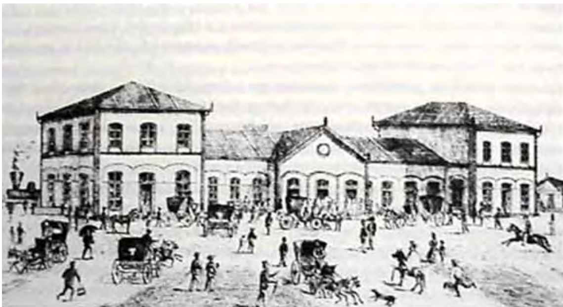
Figura 26 – Estação da Cia Paulista antes de sua primeira reforma em 1884.
