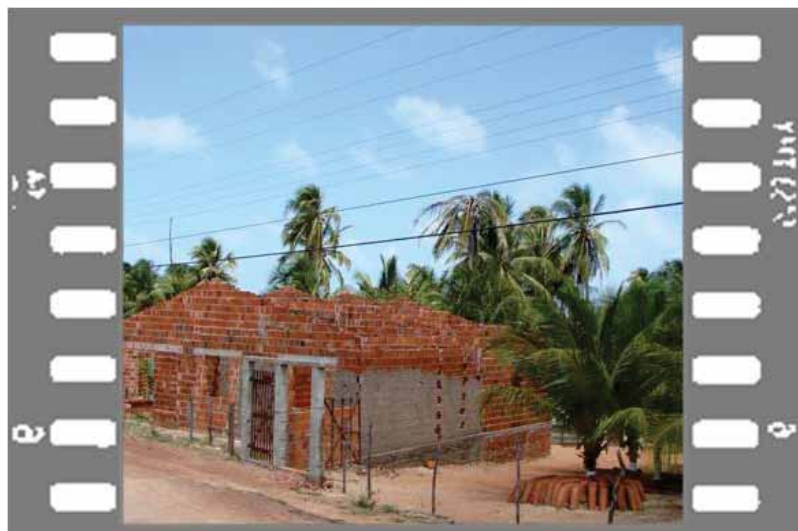
Figura 31. Construção de habitações dos comunitários em alvenaria Fonte: Araripe (2011).
