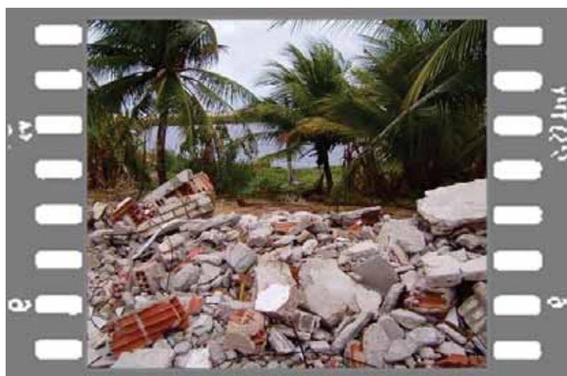
Figura 32. Escombros da demolição de residência de veranista. Fonte: Araripe (2011).
