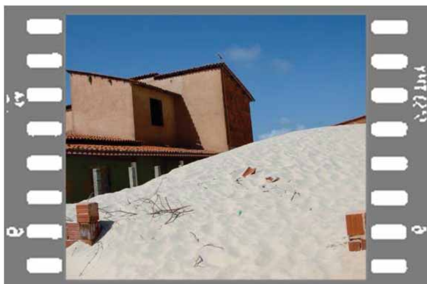
Figura 14. Segunda residência invadida pela duna móvel. Fonte: Araripe (2011).
