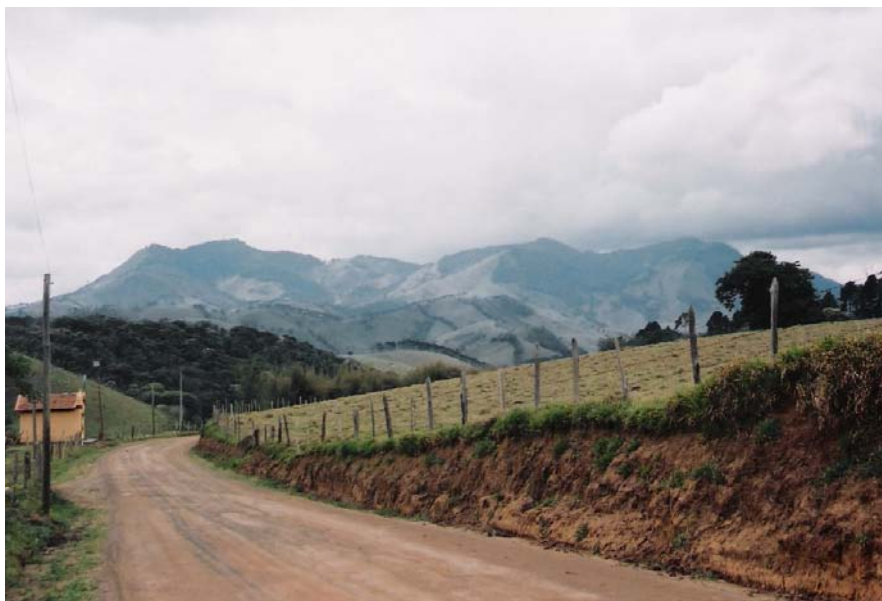
Figura 44 - Estrada do Domínio Norte Autor: André Pavani Grecco
