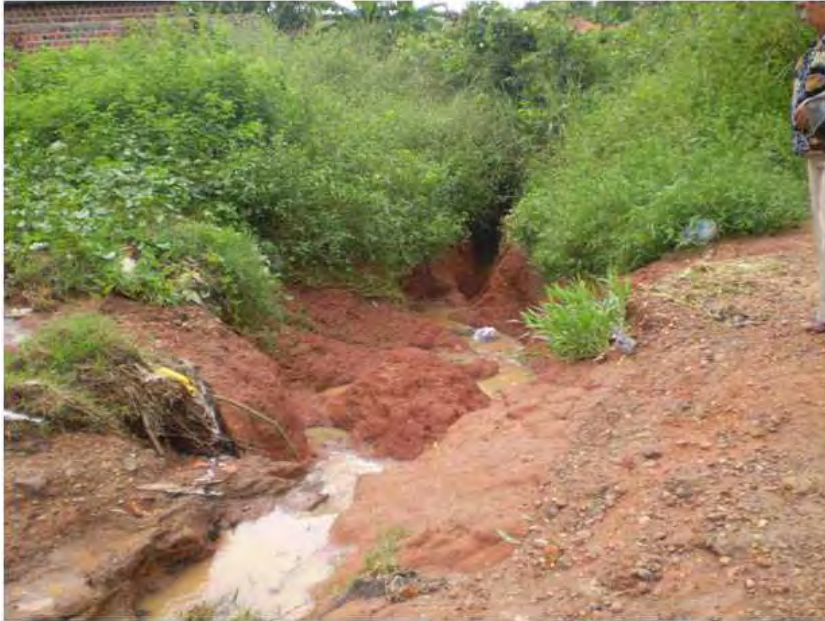
FIGURAS 10 – Erosão Rua da Linha de Transmissão da CHESF Bairro Cidade Nova no período das chuvas no ano de 2009. Fonte: Silva, J.O. (2009).
