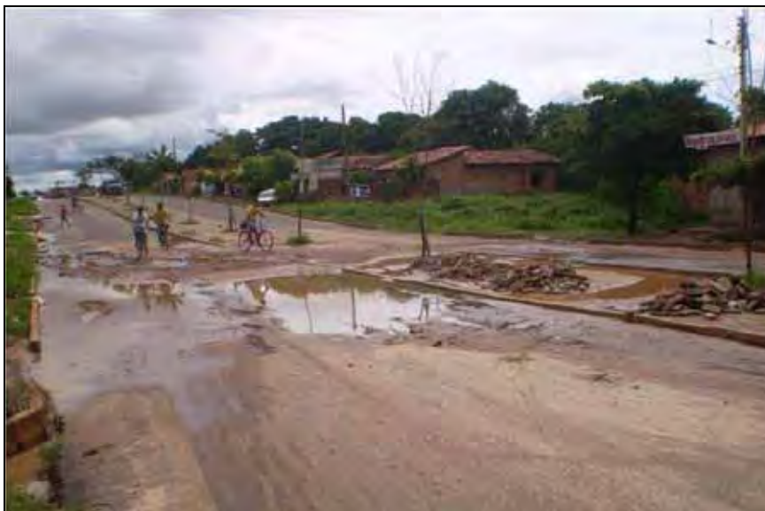
FIGURA 32 – Pavimentação em péssimas condições. Fonte: Silva, J O. (2008).
