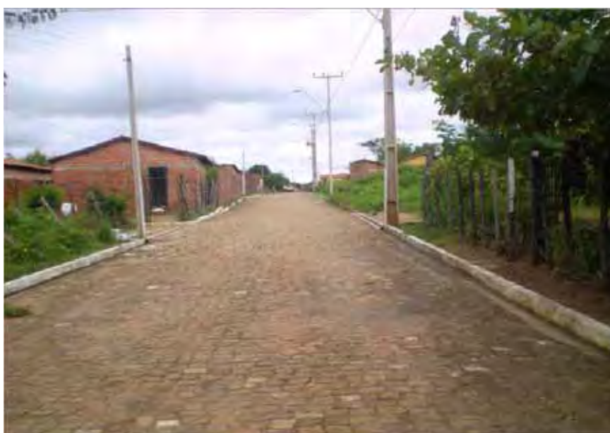
FIGURAS 33 – Pavimentação de Ruas em paralelepípedo. Fonte: Silva, J. O. (2008).
