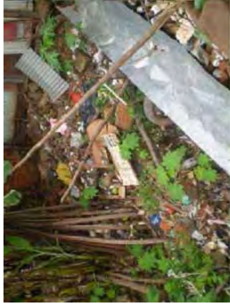
FIGURA 44 – Acúmulo de lixo 01
