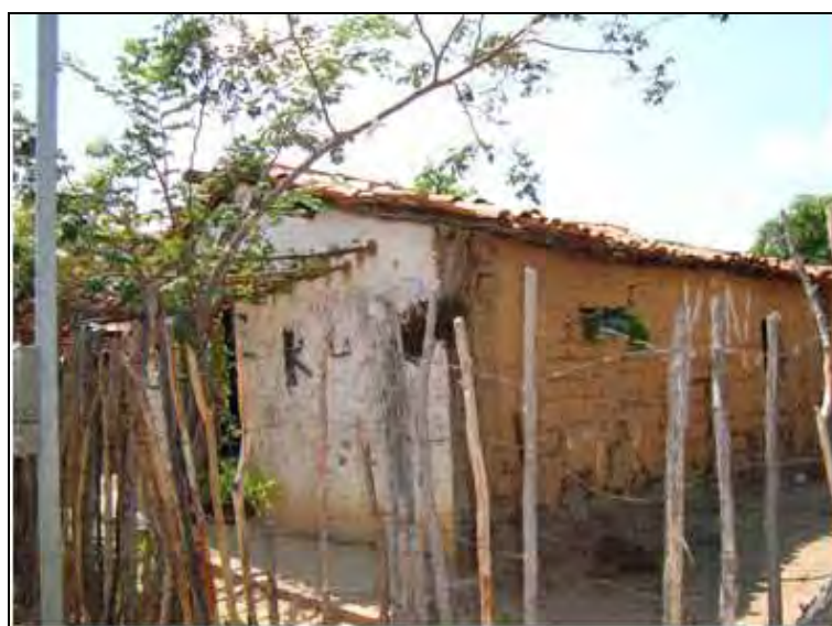
FIGURA 38 – Casa de Taipa/telha. Fonte: Silva, J.O. (2008).
