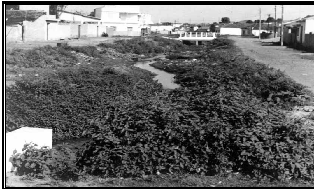
FIGURA 33 CÓRREGO DA SERVIDÃO ANTES DO INÍCIO DA CONSTRUÇÃO DA AVENIDA VISCONDE DO RIO CLARO.
