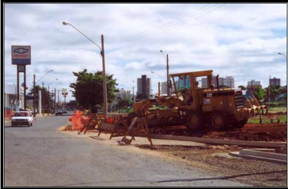
FIGURA R. 1. CONSTRUÇÃO DA PRAÇA ROTATÓRIA FRANCISCO MARCHIORI E DA PRAÇA COM ESTACIONAMENTO.
