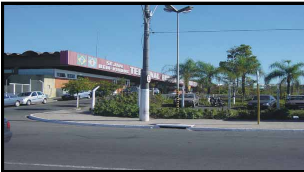
FIGURA 8. TERMINAL RODOVIÁRIO DE RIO CLARO : ESTACIONAMENTO.
