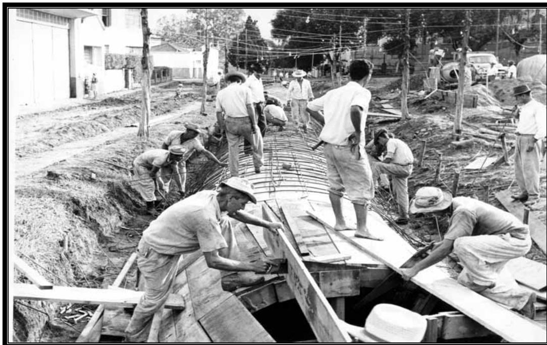
FIGURA 34 OBRAS DE CANALIZAÇÃO DO CÓRREGO DA SEERVIDÃO QUE DEU ORIGEM A AVENIDA VISCONDE DO RIO CLARO.
